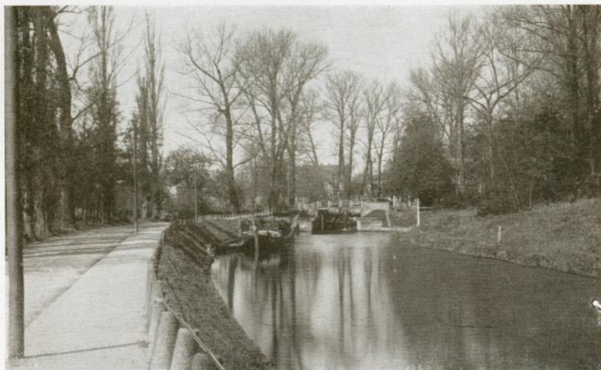
Bromberger Kanal vor der III. Schleuse.
