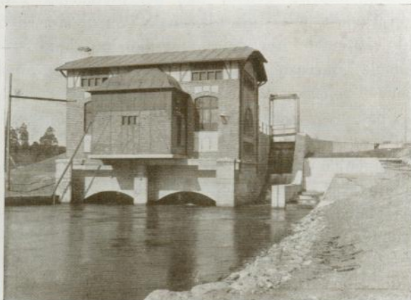
Turbinenhaus mit Kiesschleuse und Fischpaß.
