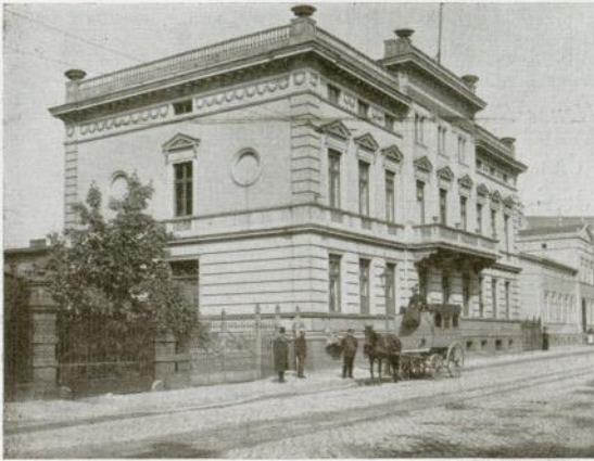
Generalkommission, erbaut von Gebr. Wulff.
