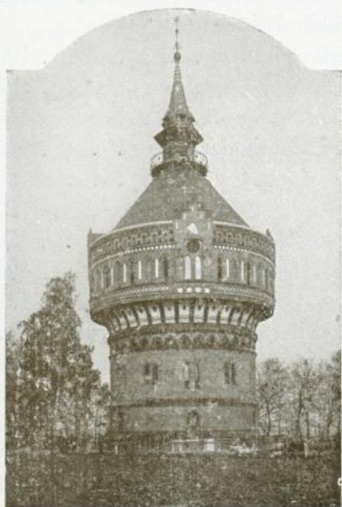
Wasserturm auf der Wißmannshöhe.
