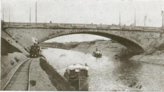
Brücke über den Teltowkanal.
