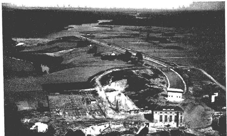
Rys. 13 Ogólny widok zapory, zbiornika, kanału i zakładu wodno-elektrycznego w Żurze na Pomorzu.
