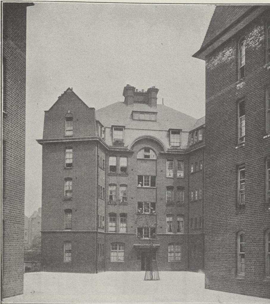
Abb. 10. Hofansicht einer Gebäudegruppe auf dem Boundary-Street-Grundstück des Londoner Grafschaftsrates.
