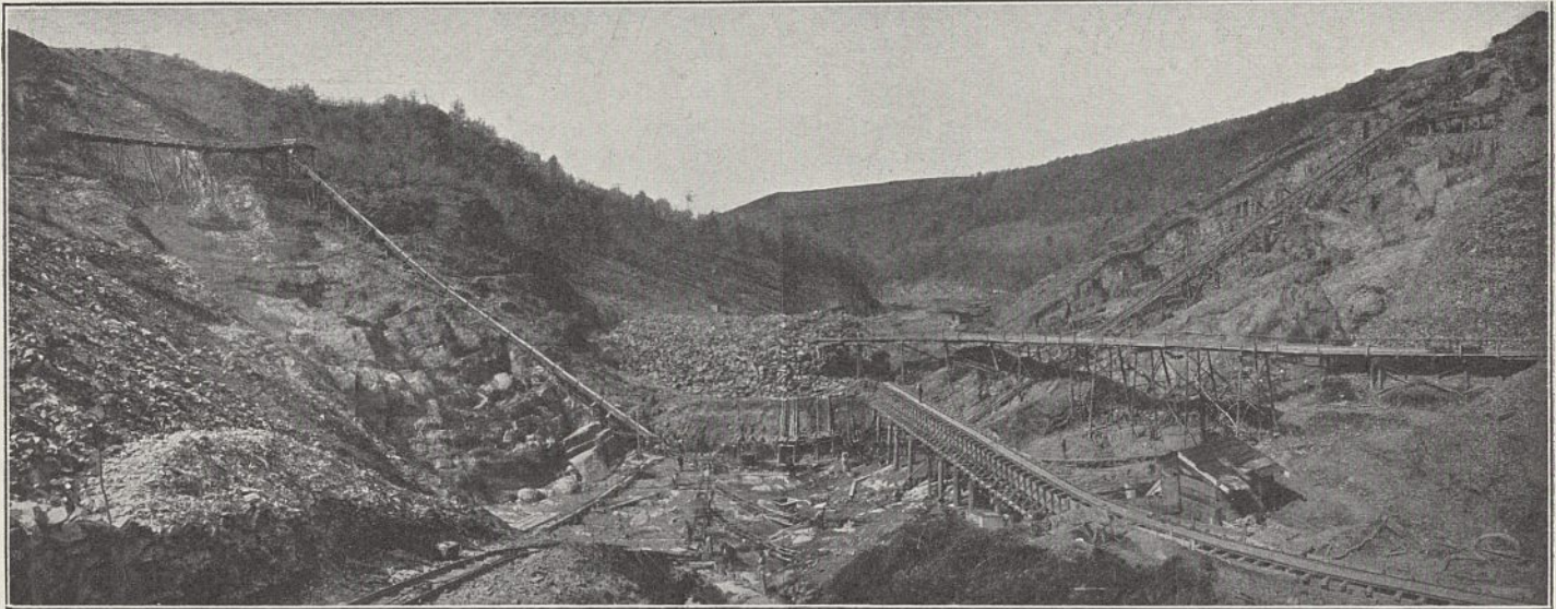
Abb. 7. Gründungsarbeiten der großen Talsperre.
