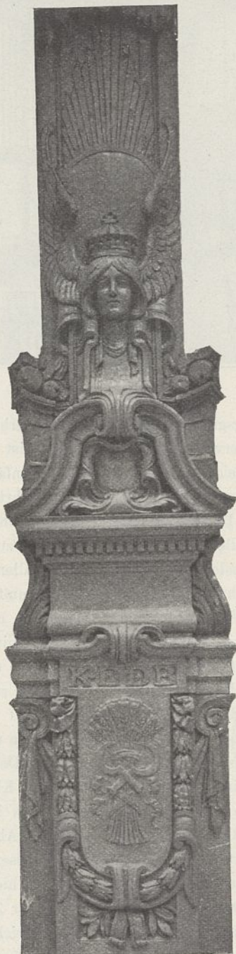
Abb. 7. Pfeiler der Nordwand im Wartesaal II. Klasse.
