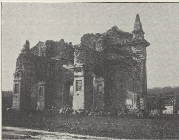
Abb. 10. S. Stefano del Bosco: Reste der 1783 zerstörten Klosterkirche.
