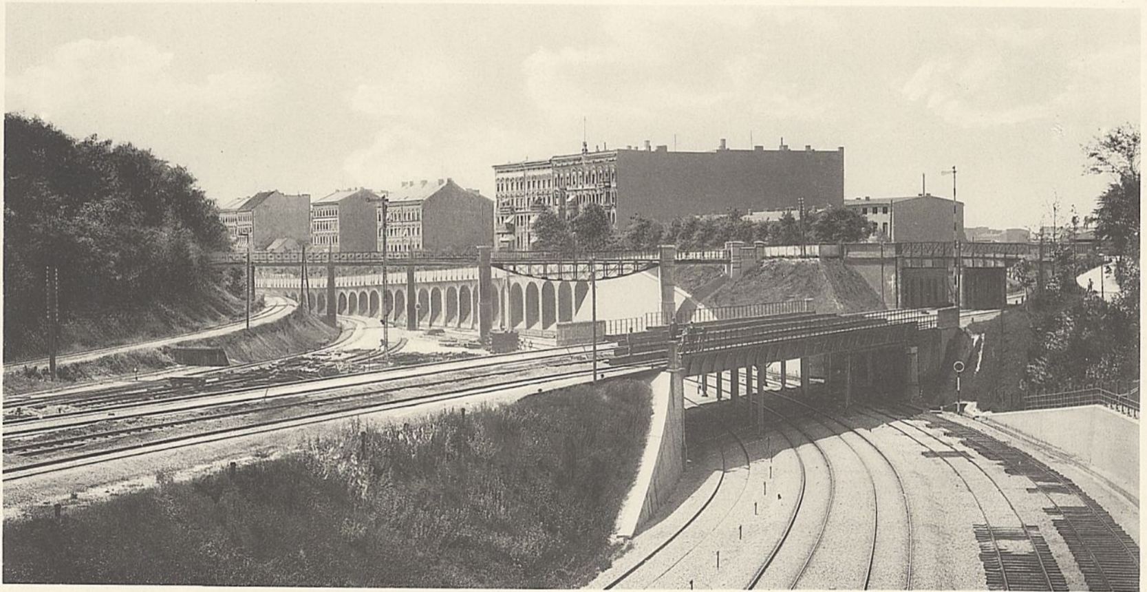
Abb. 2. Verlegung der Stettiner Eisenbahn zwischen Berlin und Pankow. Schiefe Überführung der Ringbahngleise, Humboldthainbrücke und Futtermauer an der Hochstraße.
