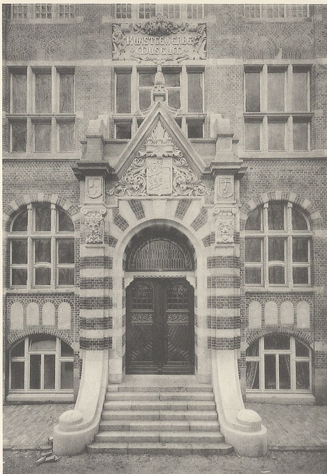
Abb. 1. Hauptportal auf der Ostseite.
