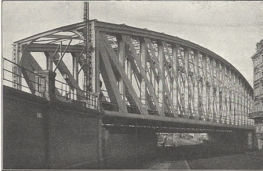
Abb. 15. Zweigleisiger Überbau der Unterführung der Liesenstraße.
