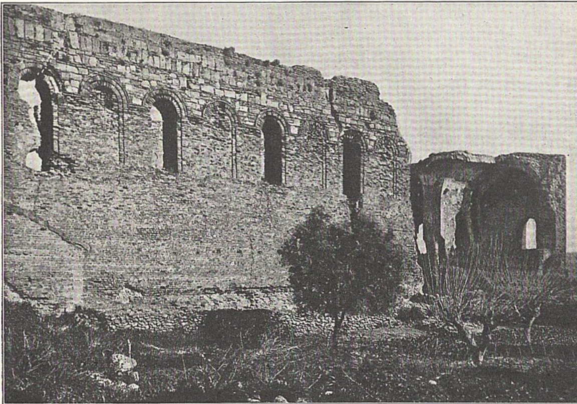
Abb. 2. Santa Maria della Roccelletta. Blick von der Südseite in das Presbyterium.
