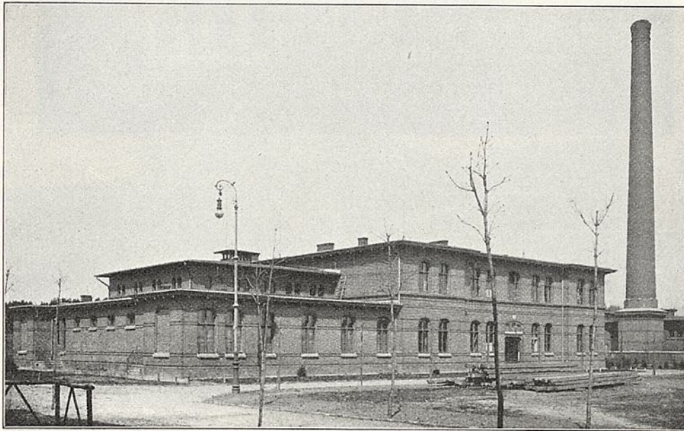
Abb. 4. Werkstättengebäude und Badeanstalt.
