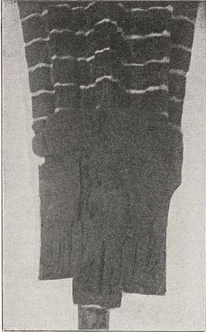
Abb. 12. Gewölbefänger im Kreuzgang (Ecke Ost – Nordflügel).
