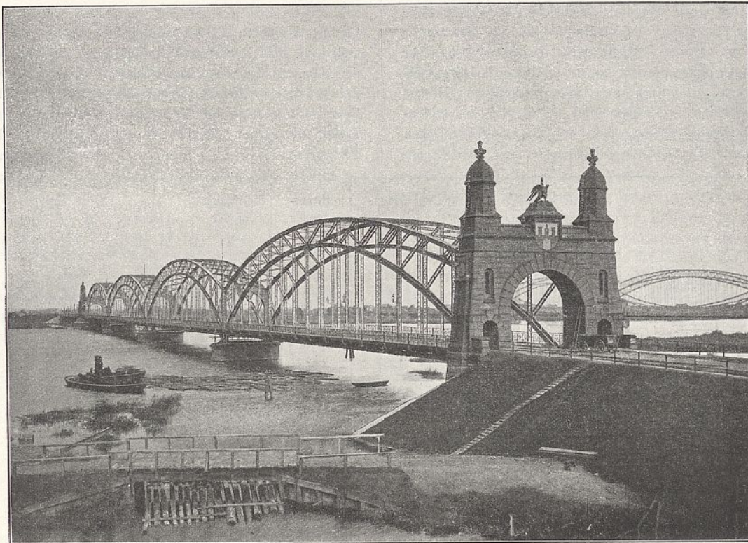
Abb. 2. Gesamtansicht der Brücke.
