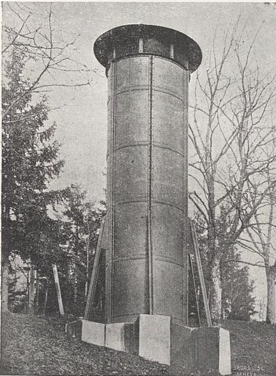
Abb. 57. Sihlwerk. Ansicht des Luftschaftes der Rohrleitung.
