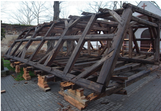
Il. 8. Część dolna usuniętej konstrukcji dachowej nad nawą główną kościoła w Ujeździe (fot. M. Warchoł)
