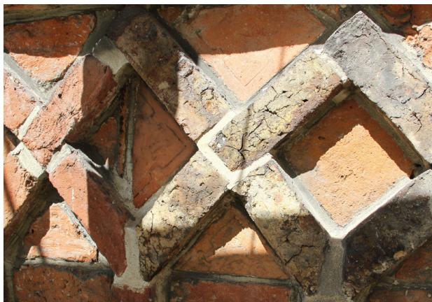
II. 3. Elewacja południowa prezbiterium kościoła, fryz dekoracyjny z nowożytnymi płytkami posadzkowymi, stan obecny (fot. M. Dąbkowska)
