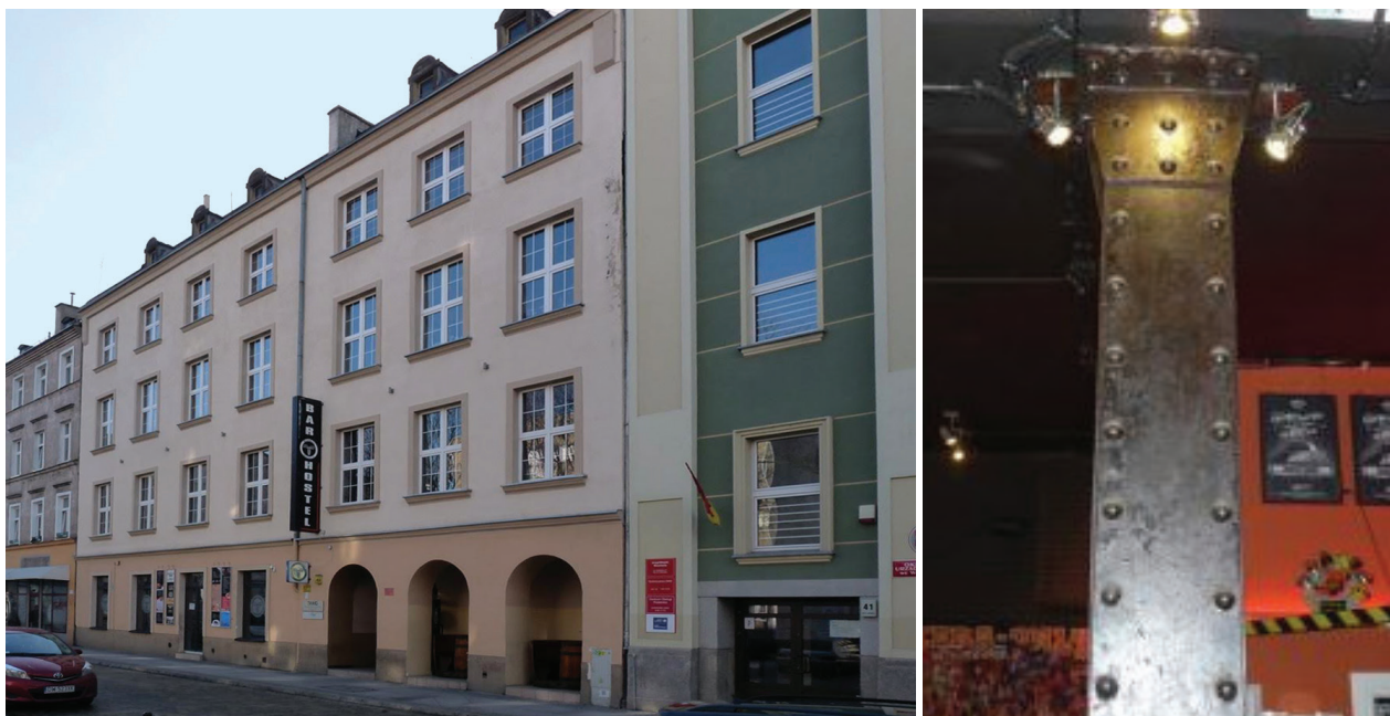
Il. 8. Fasada budynku przy ul. Kotlarskiej 42, stan z 2016 r. oraz zdjęcie ukazujące stalowy słup pierwotnej konstrukcji, wyeksponowany jako element wystroju baru (fot. P. Kirschke, 2015, 2016)
