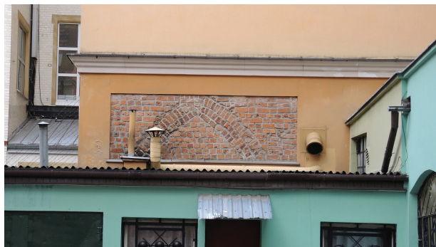
Il. 2. Przykład fragmentarycznego eksponowania średniowiecznych elementów budynku – Wrocław, ul. Więzienna (fot. R. Zapłata, 2015)
