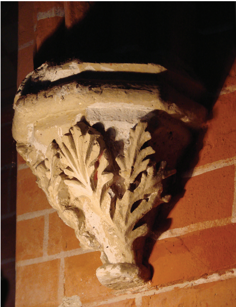
Kościół cysterski w Doberanie, wspornik (fot. E. Łużyniecka) Cistercian church in Doberan, cantilever (photo by E. Łużyniecka)
