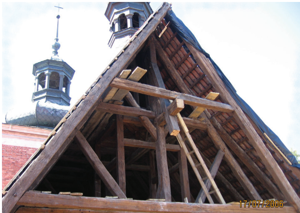
Il. 6. Konstrukcja dachu kościoła pw. św. Jana we Włocławku w trakcie rozbiórki (fot. R. Skorupa)
