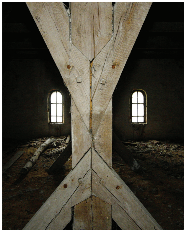
Il. 3. Sposób obróbki elementów więźby dachowej kościoła w Pawłowie Kościelnym (fot. M. Warchoł)
