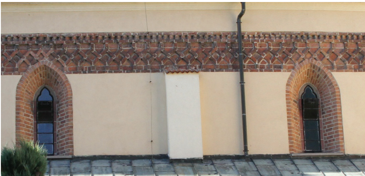
Il. 2. Elewacja południowa kościoła, średniowieczny fryz i współczesne otwory okienne wprowadzone w czasie odbudowy realizowanej od 1945 r., stan obecny (fot. M. Dąbkowska)
