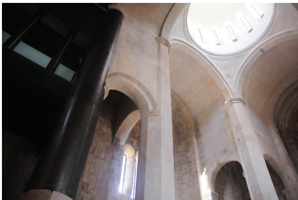
Il. 6. Katedra Bagrata, wewnątrz, widok konstrukcji empory nawy północnej (fot. Z. Świechowski, 2014)
