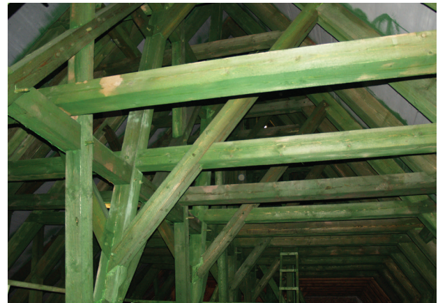
Il. 7. Odtworzona konstrukcja dachu kościoła pw. św. Jana we Włocławku (fot. P. Tuliszewski)
