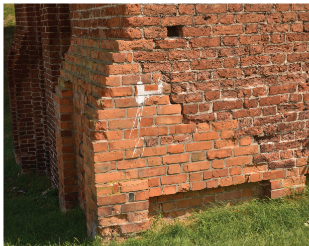
Il. 5. Fragment średniowiecznego gdaniska w Kwidzynie. Przykład czytelności i odróżnialności ingerencji (współczesnych uzupełnień) (fot. R. Zapłata, 2015)
