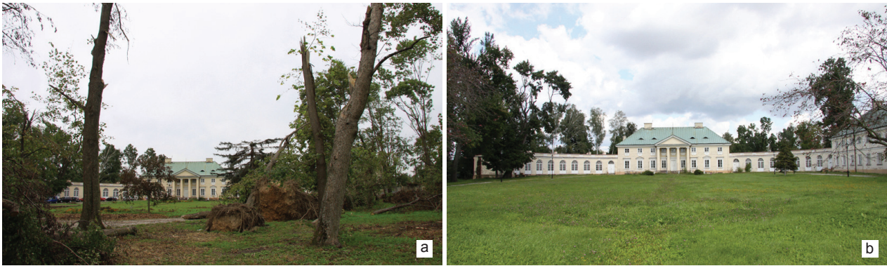
Il. 3. Elewacja frontowa pałacu w Białaczowie: a) po zniszczeniach wskutek wichury w 2011 r., b) sytuacja po uporządkowaniu wiatrołomów w 2014 r. (fot. M. Milecka)
