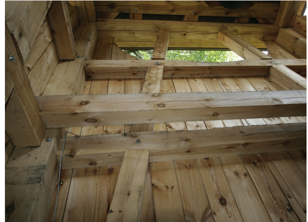
Il. 9. Odtworzona konstrukcja ciesielska dzwonnicy w Nadarzynie (fot. M. Warchoł)
