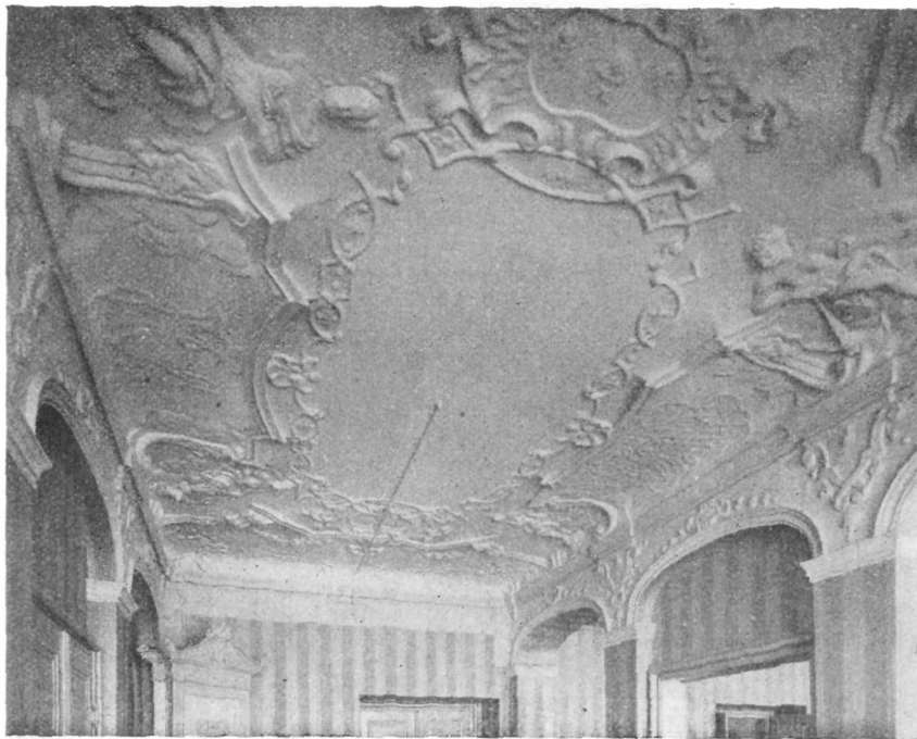
Görlitz, Reißstraße 30. Saal im 1. Stockwerk. Aufn. R. Scholz in Görlitz.
