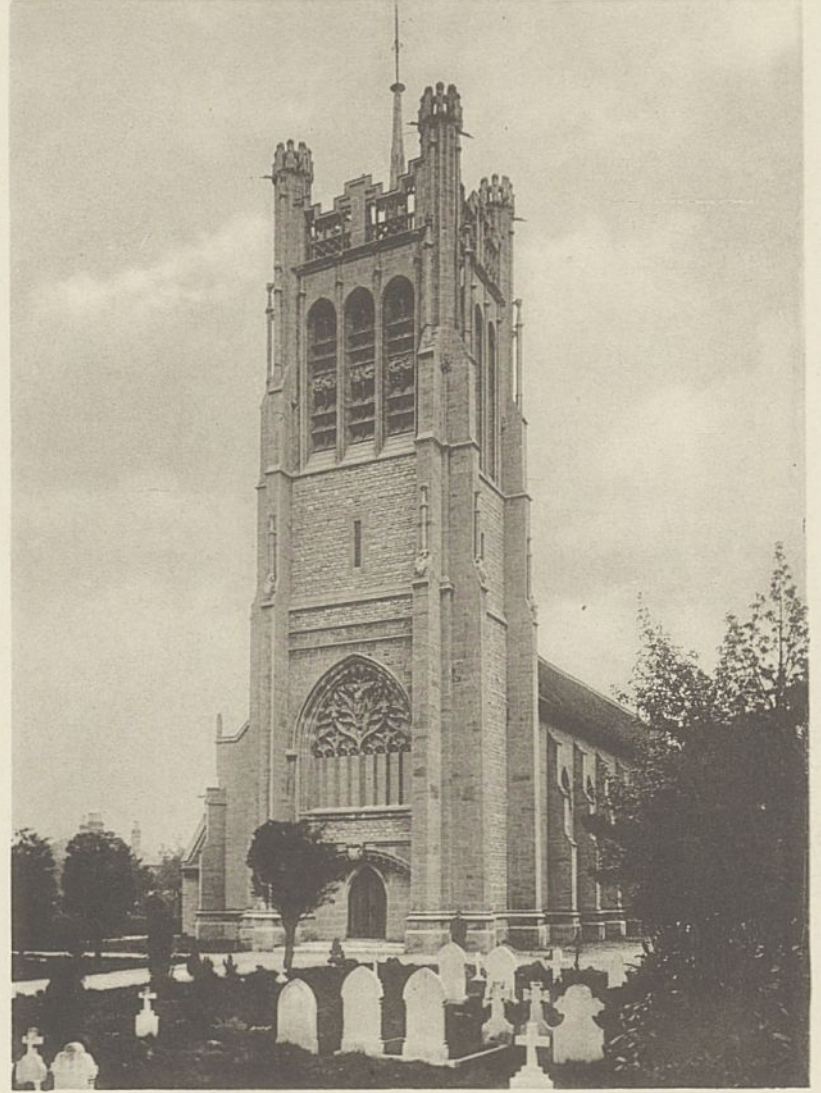
Abb. 2. Clemenskirche in Boscombe bei Bournemouth. Architekt J. D. Sedding.
