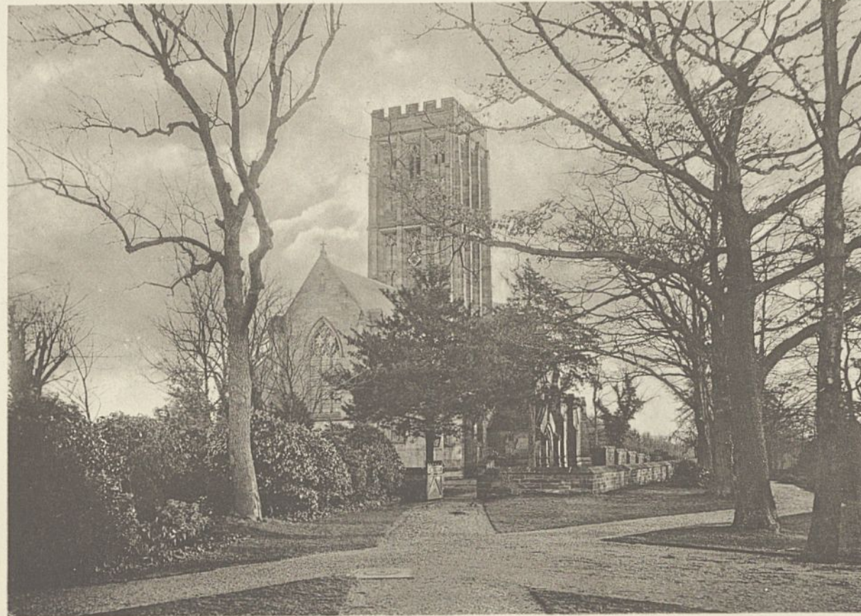
Abb. 1. Kirche in Hoar Cross. Architekten Bodley u. Garner.
