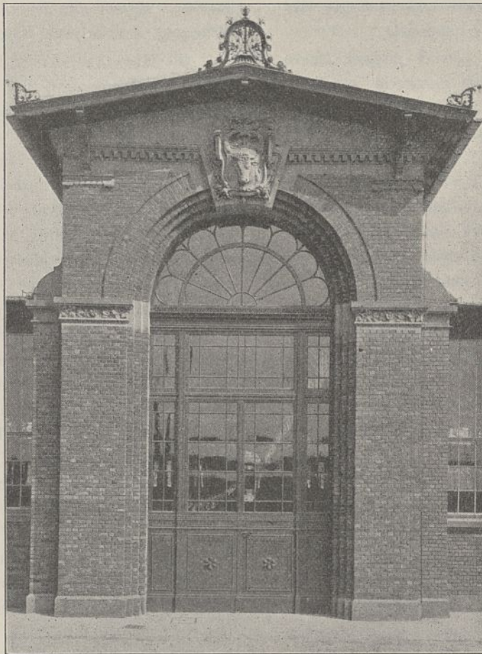
Haupteingang der Großvieh-Verkaufshalle.
