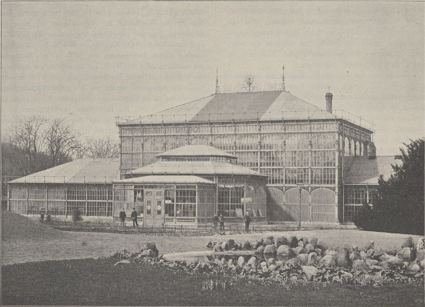
Vorderansicht der Gewächshausanlage.
