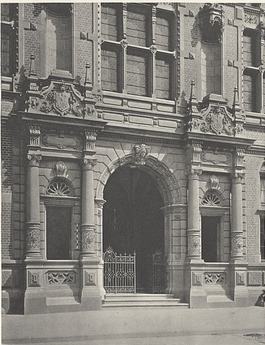
Abb. 2. Haupteingang der Südfront.
