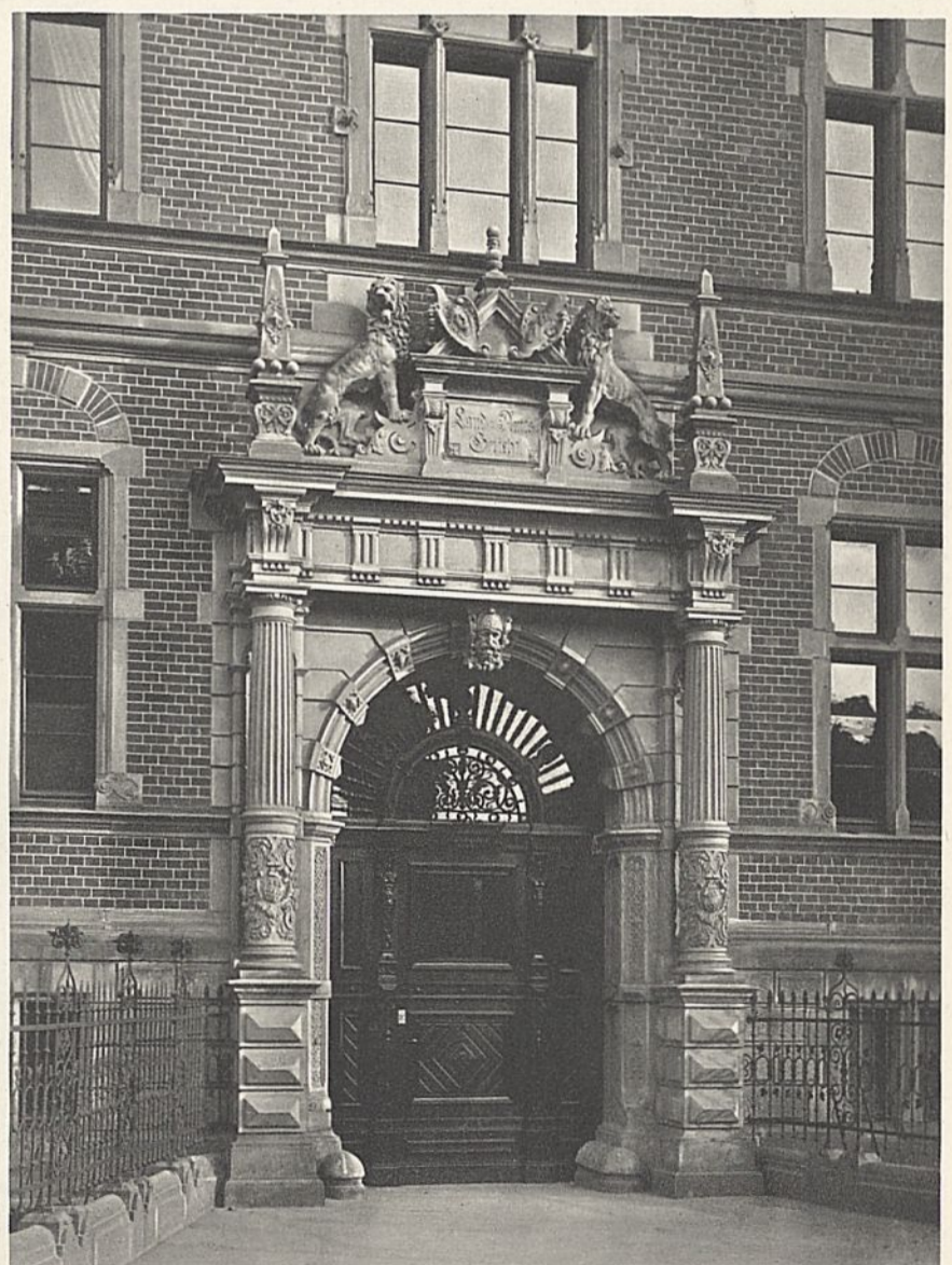
Abb. 3. Nebeneingang der Nordfront.
