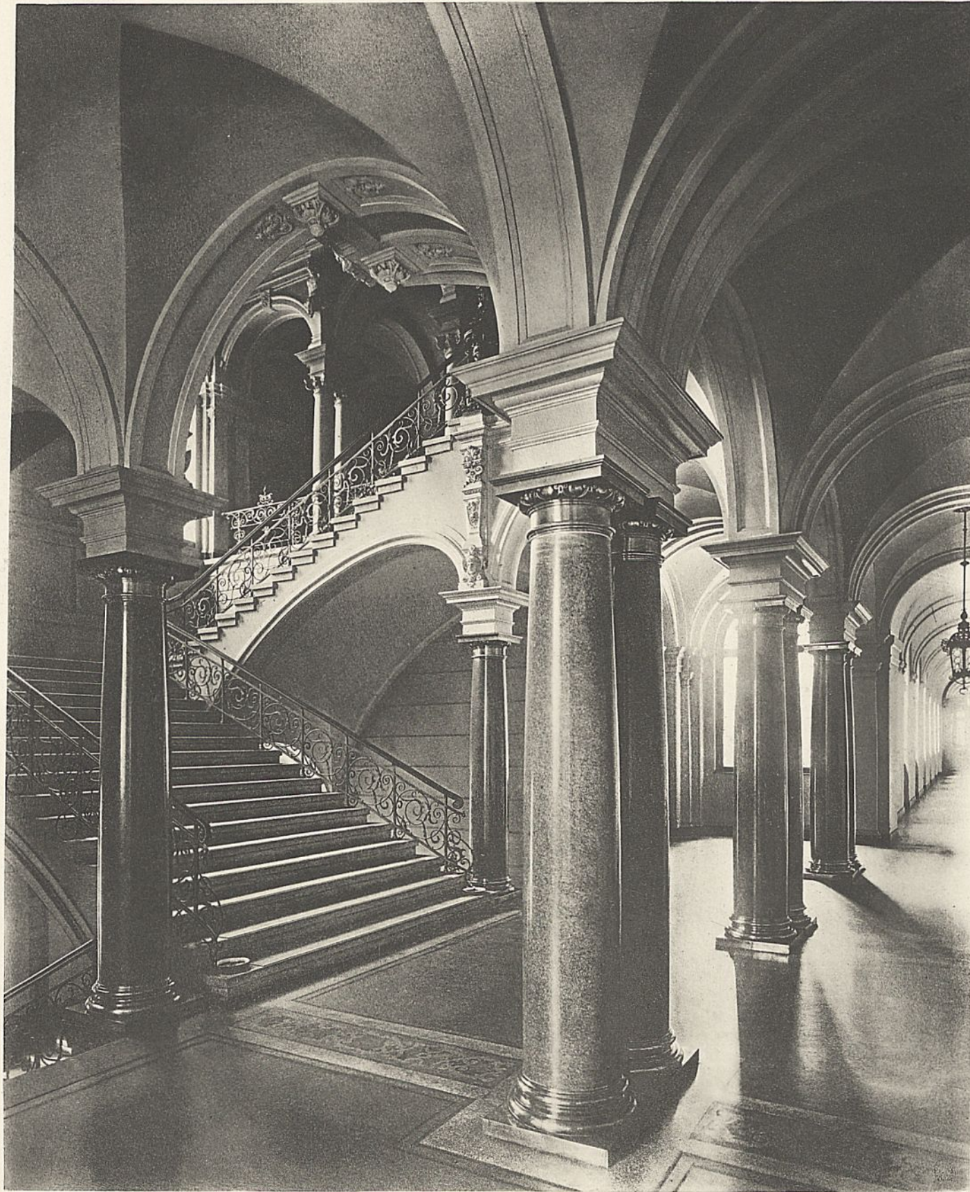
Treppenhaus im Erdgeschoss. Nordflügel.
