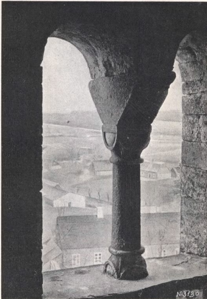
Ryc. 9. Wysocice. Kościół parafjalny. Przejście wieży.
