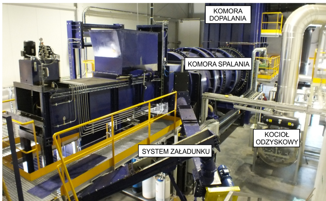
Fot. 1. Instalacja termicznego przekształcania odpadów z odzyskiem energii
