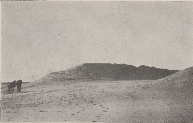
Abb. 4. Verfallener Kanal mit hohen Seitendämmen.
