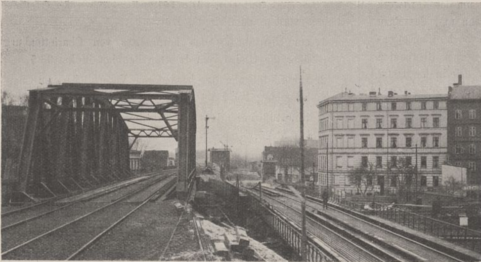
Abb. 3. Alte Haveldrehbrücke mit einem Überbau der neuen Brücke für die Personengleise.
