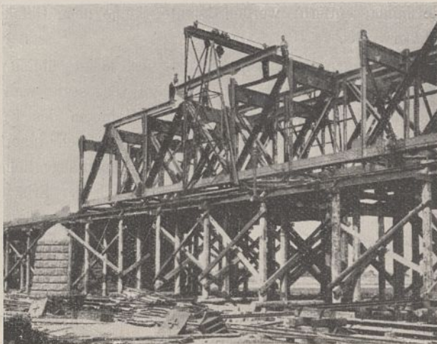
Abb. 52. Errichtung der Vorlandüberbauten.
