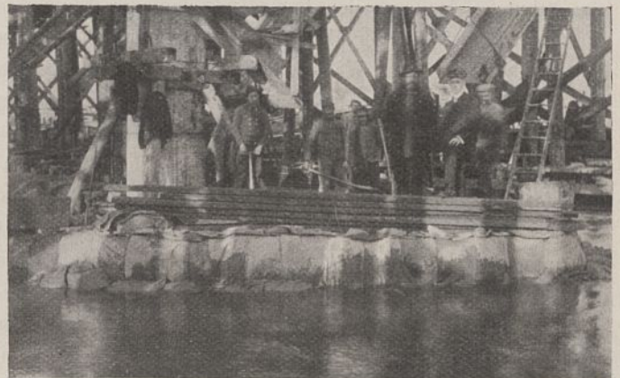
Abb. 50. Linker Strompfeiler während des Baues im Hochwasser.
