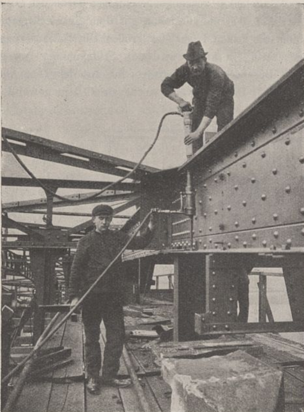
Abb. 54. Nieten mit Drucklufthammer und Druckluftgegenhalter.
