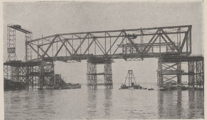
Abb. 56. Fertig aufgestellter und ausgerüsteter Rüstträger.
