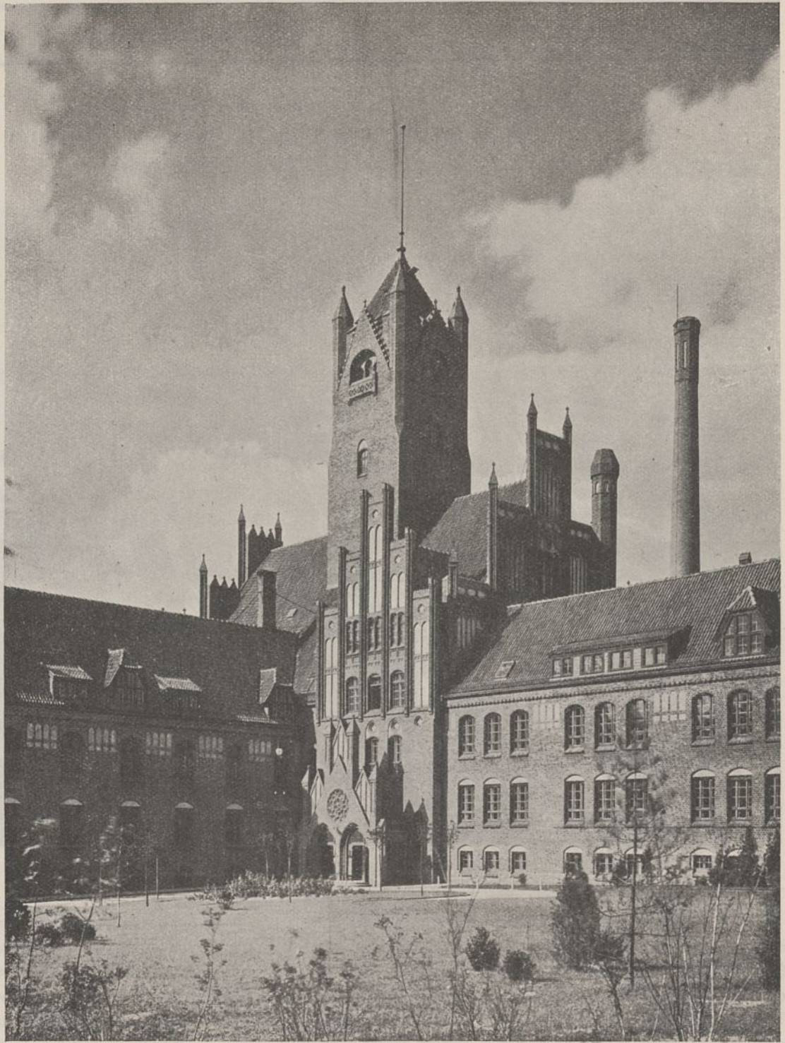
Abb. 2. Mittelbau mit Hauptzugang von der Landseite und anstoßendem Unterrichtsflügel.
