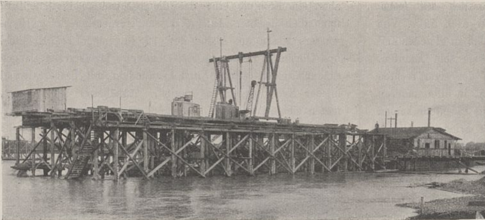
Abb. 51. Rechter Strompfeiler während des Absenkens im Hochwasser mit dahinter liegender Kraftanlage.
