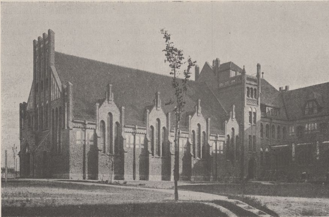
Abb. 7. Turnhalle. Ansicht von Nordwesten.
