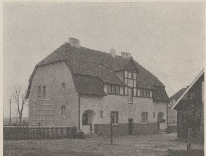
Abb. 14. Hofseite des Dreifamilienhauses.
