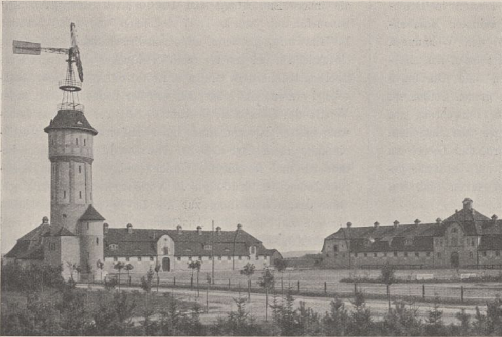
Abb. 17. Wasserturm. Ansicht von Westen.
