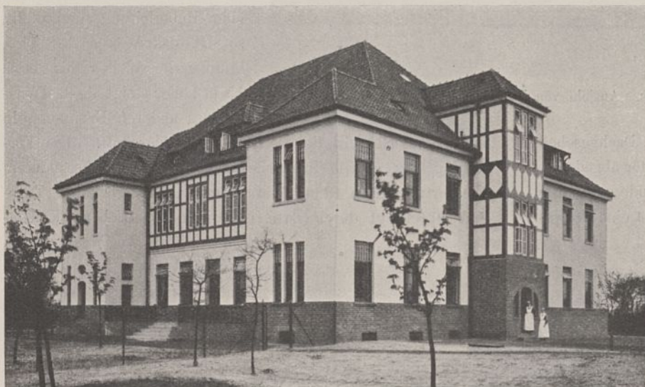
Abb. 1. Pflegestation für 50 Frauen. Ansicht von Südosten.
