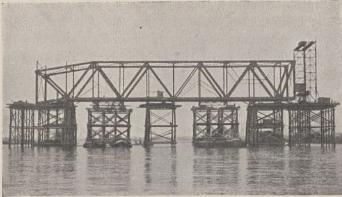
Abb. 58. Der ausgerüstete Rüstträger mit untergefahrenen Schiffsrüstungen.
