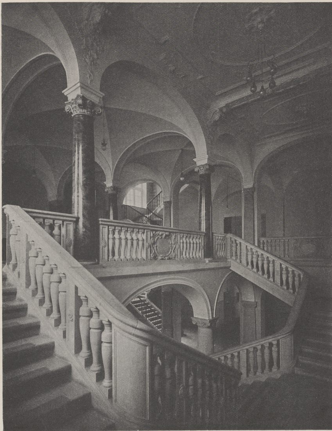
Abb. 9. Haupttreppe im Lehrgebäude.
