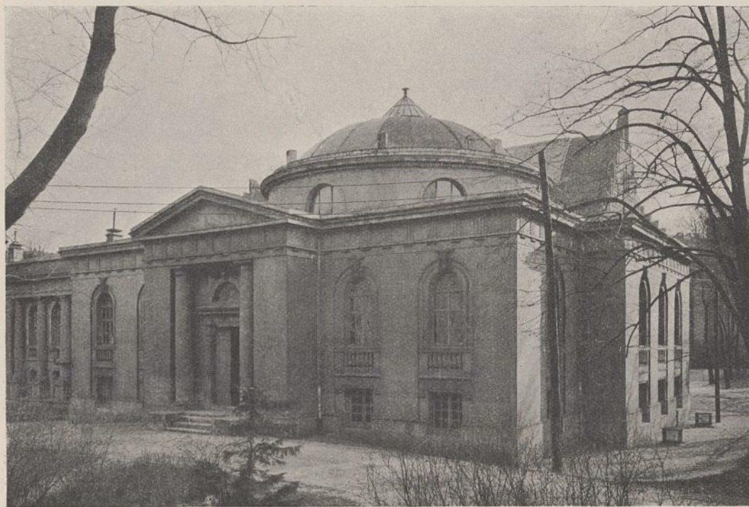
Abb. 6. Ansicht mit dem linksseitigen Anbau von 1873.
