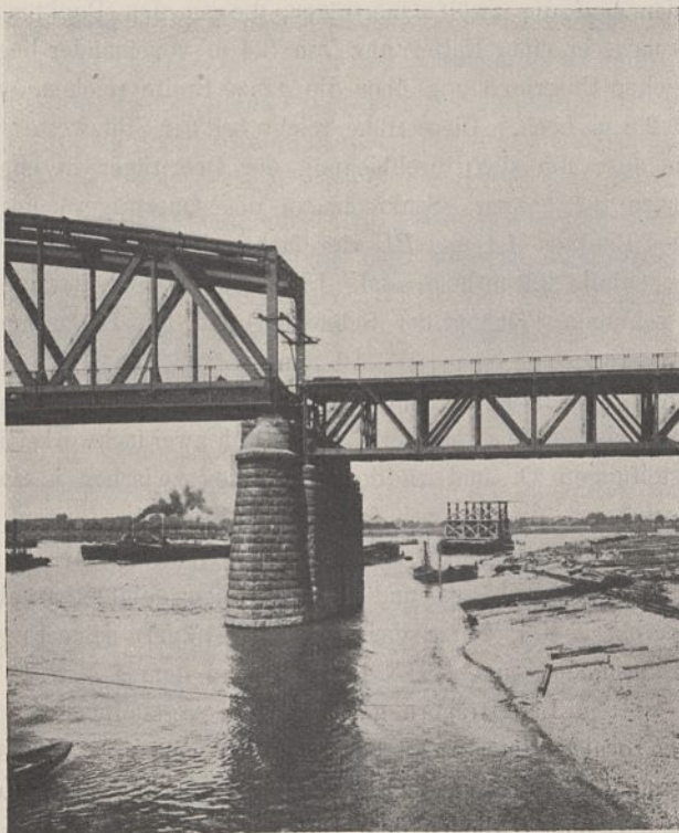
Abb. 12. Rechter Strompfeiler.
