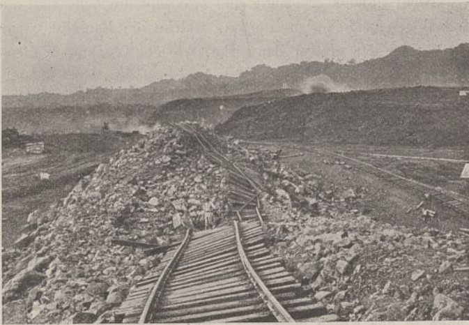
Abb. 22. Sackung am südlichen Böschungsfuße des Gatundammes.
