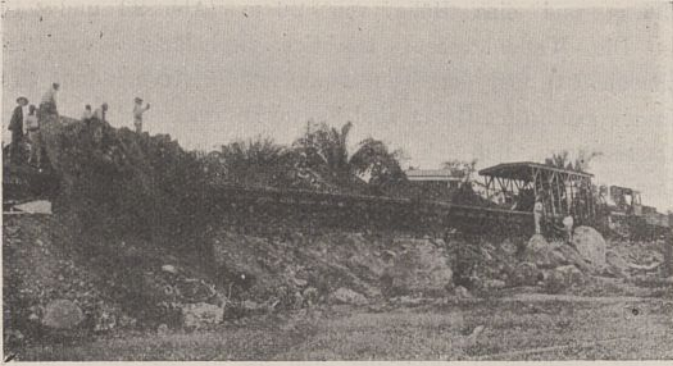
Abb. 18. Entladen der Förderwagen durch Räumer.
