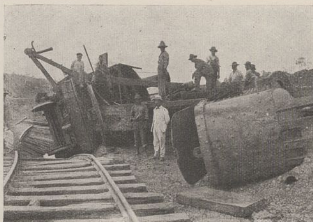
Abb. 17. Umgestürzte Dampfschaufel.
