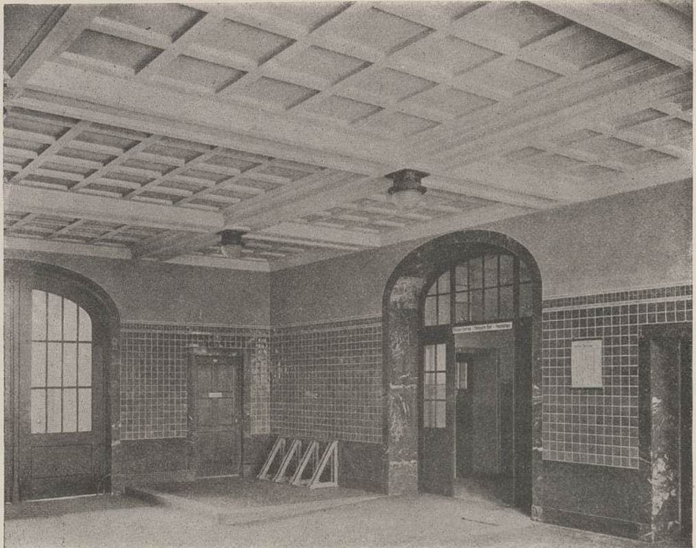
Abb. 6. Haupteingangshalle im Verwaltungsgebäude.
