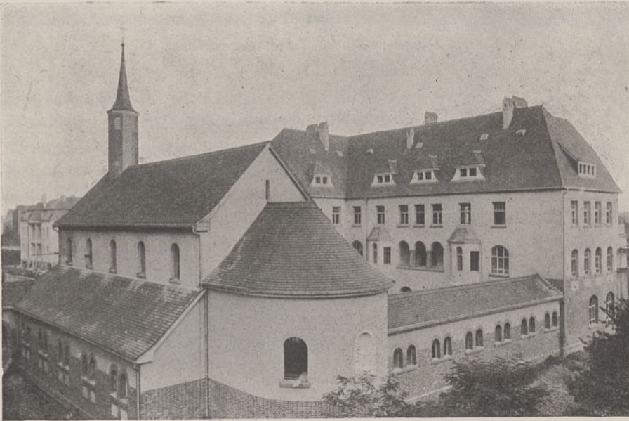
Abb. 4. Blick auf Kapelle und Schwesternhaus von Nordwesten.
