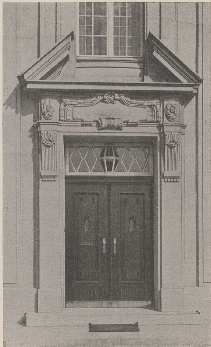
Abb. 19. Haupteingang an der Cäcilienallee.
