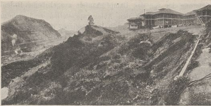
Abb. 11. Rutschung im Einschnitt bei Kulebra.
