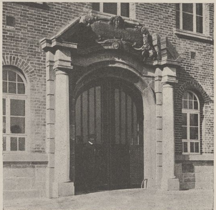
Abb. 7. Haupteingang des Verwaltungsgebäudes.
