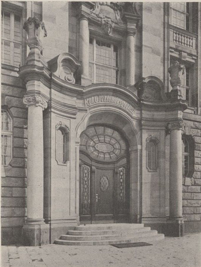
Abb. 7. Haupteingang an der Cäcilienallee.
