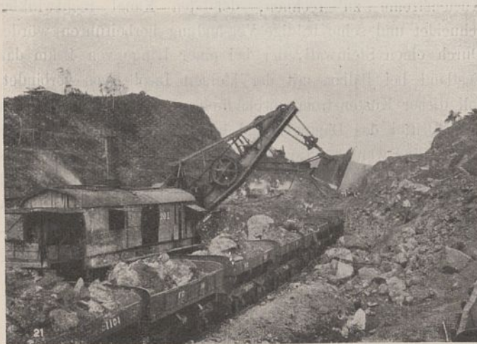
Abb. 21. Dampfschaufel nach Entleerung des Kübels über dem Förderwagen.
