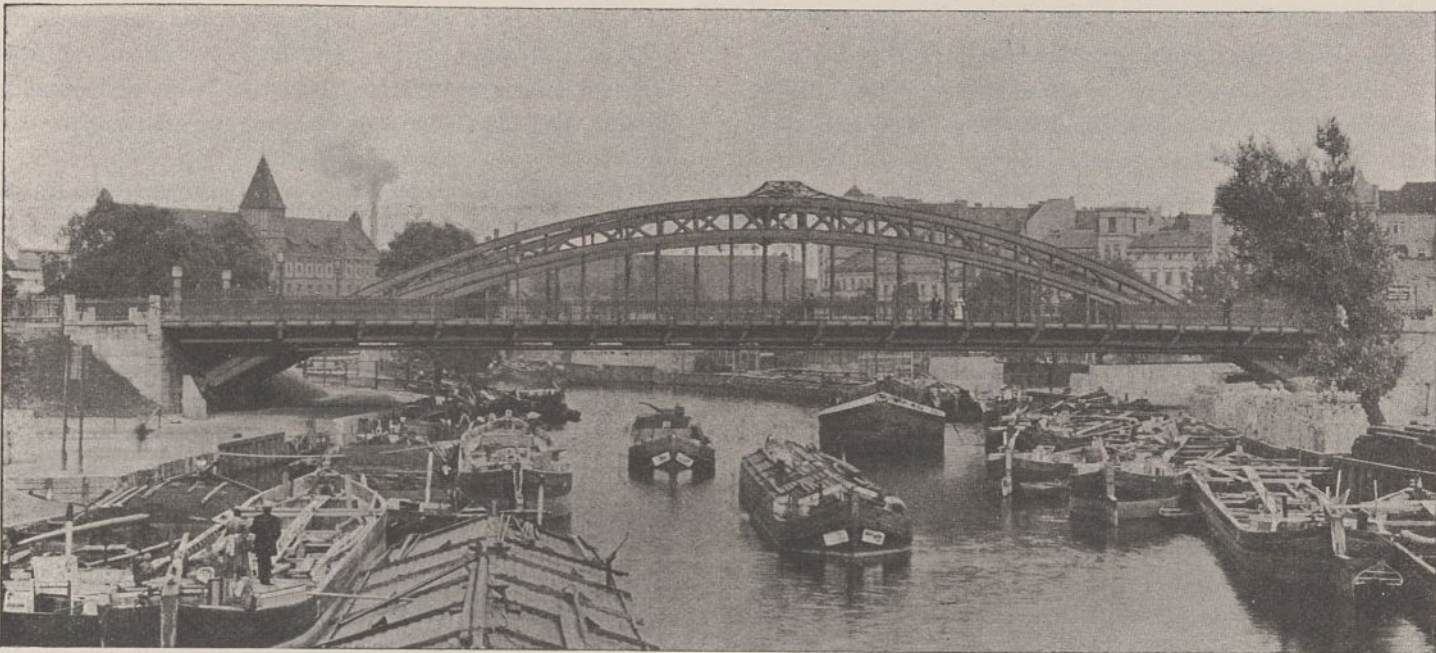
Abb. 6. Ansicht von Westen.
