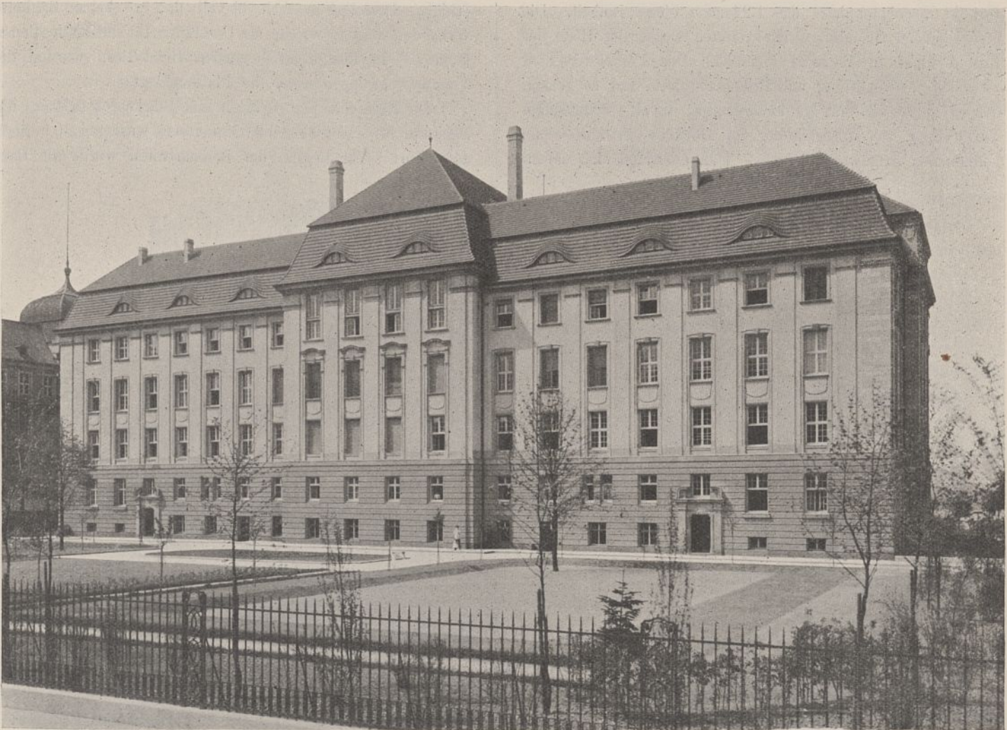
Abb. 6. Rückfront an der Emmericher Straße.
