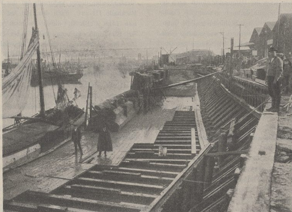
Abb. 1. Bau der Ufermauer vor dem alten Bohlwerk.
