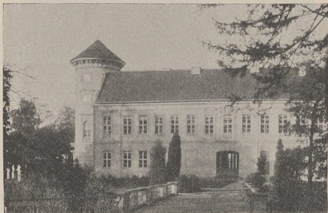
Abb. 10. Schloß Rheinsberg. Altes Herrenhaus, Südseite. Zeitschrift f. Bauwesen. Jahrg. LXI.
