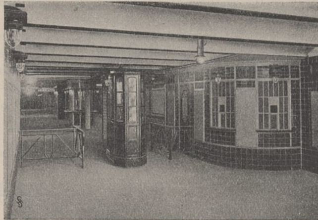
Abb. 25. Vorraum der Haltestelle Hauptstraße.
