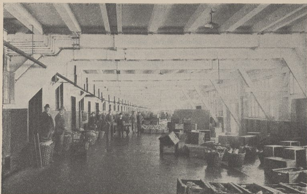
Abb. 2. Alte Versteigerungshalle I.
