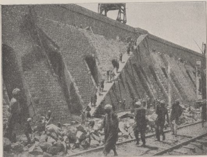
Abb. 10. Verstärkungsarbeiten am Assuandamm.
