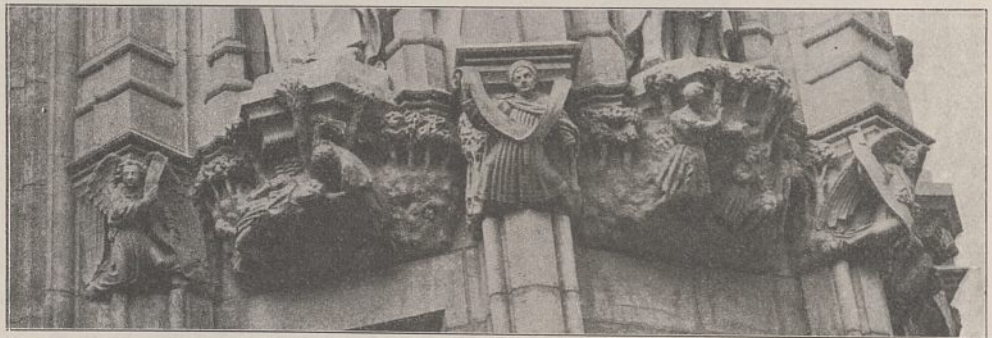
Abb. 16. Kragsteine vom Erdgeschoß des linksseitigen Türmchens. Ostseite.
