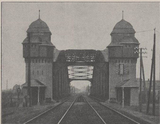
Abb. 6. Südansicht der neuen Brücke.
