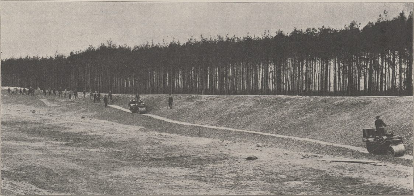
Abb. 7. Einwalzen des Tons auf den Böschungen mit den Petroleummotorwalzen.
