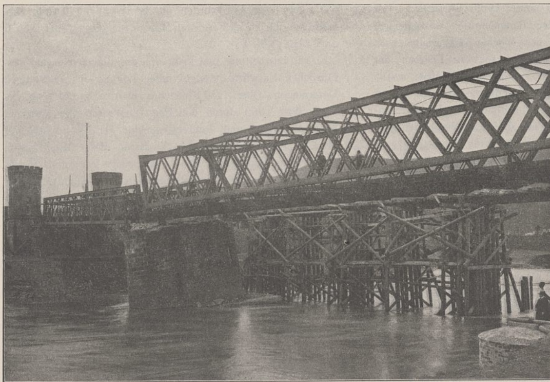
Abb. 5. Flußpfeiler und Überbauten der alten Lahnbrücke nach dem Februarhochwasser 1909.
