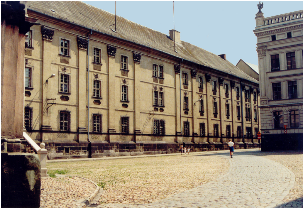
Plac Solny w Nysie. Widok od strony kościoła
