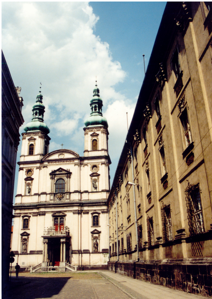
Fasada kościoła NMP na pl. Solnym w Nysie
