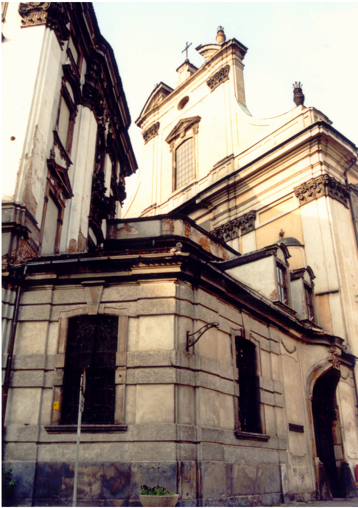
Łącznik budynków Uniwersytetu i Kościoła Uniwersyteckiego
