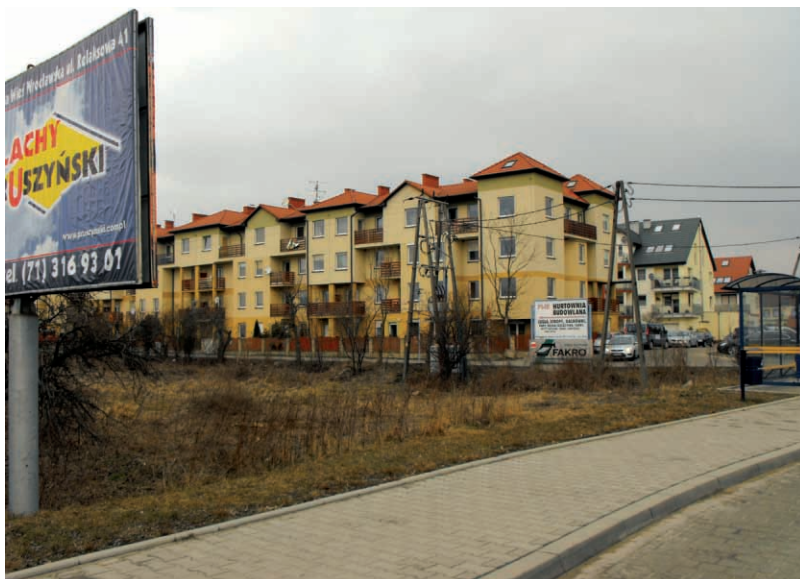
Fot. 29. Nowa zabudowa mieszkaniowa wielorodzinna w miejscowości Bielany Wrocławskie, gmina Kobierzyce (fot. M. Hełdak)
