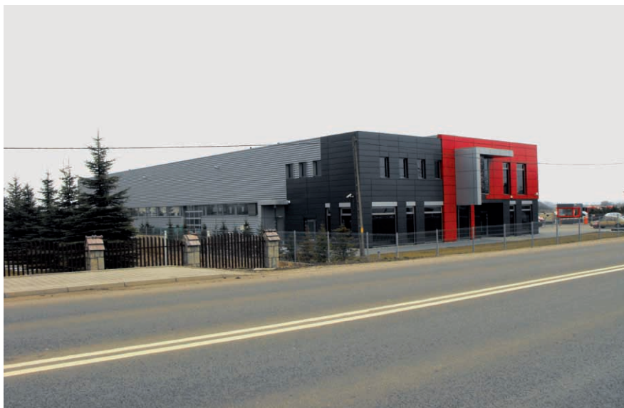
Fot. 13. Zabudowa usługowa zlokalizowana wzdłuż trasy wylotowej w kierunku Kudowa Zdrój – Bielany Wrocławskie, gmina Kobierzyce (fot. M. Hełdak)
