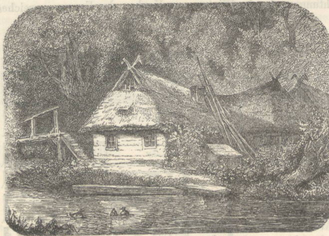
Fig. 2613. Wendisches Bauernhaus im Spreewalde.
