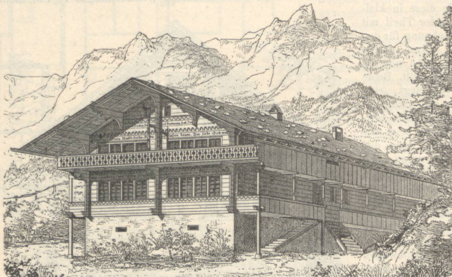
Fig. 2651. Bauernhaus in Grindelwald. Schweiz.
