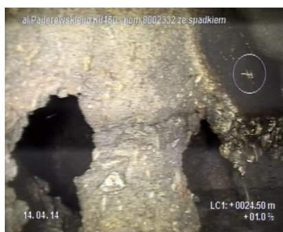
Fot. 3. Otwory w ścianie kanału \varnothing 450 mm
