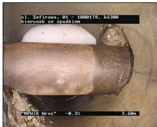
Rys. 4. Przecisk w istniejącym kanale [13]
