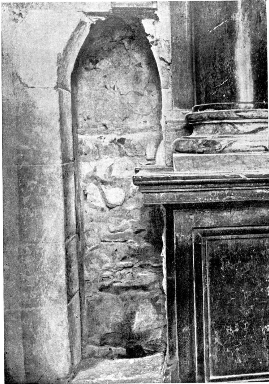
Fig. 33. Stary otwór obok portalu kaplicy Wazów.
