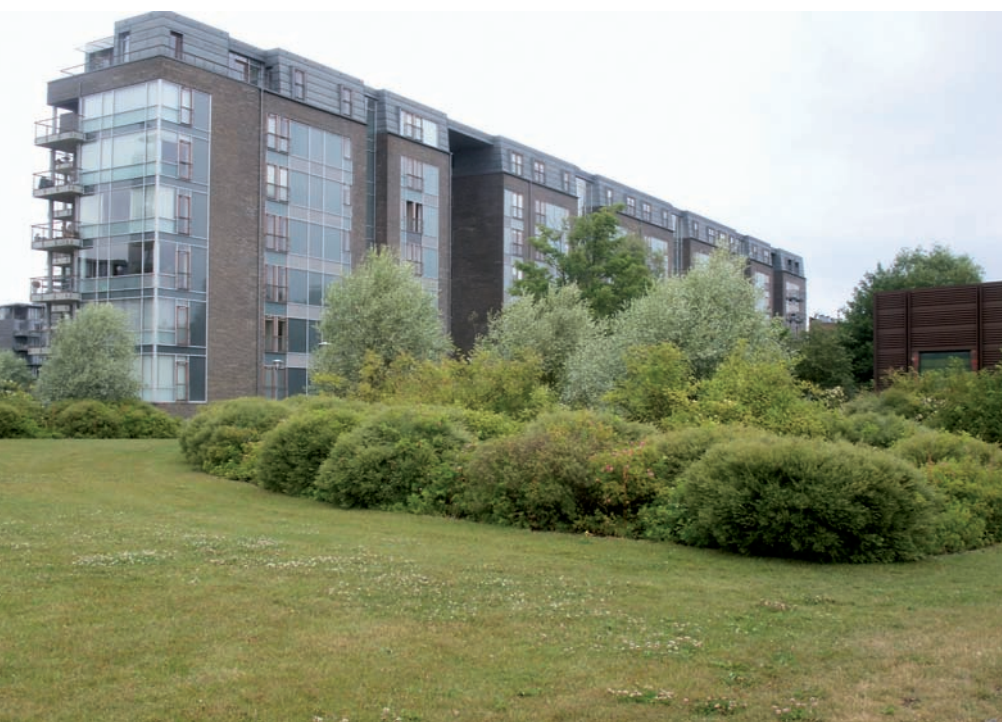
Ryc. 3. Amagerbro w Kopenhadze, zielone podłogi ograniczające strefy zabudowy mieszkaniowej
