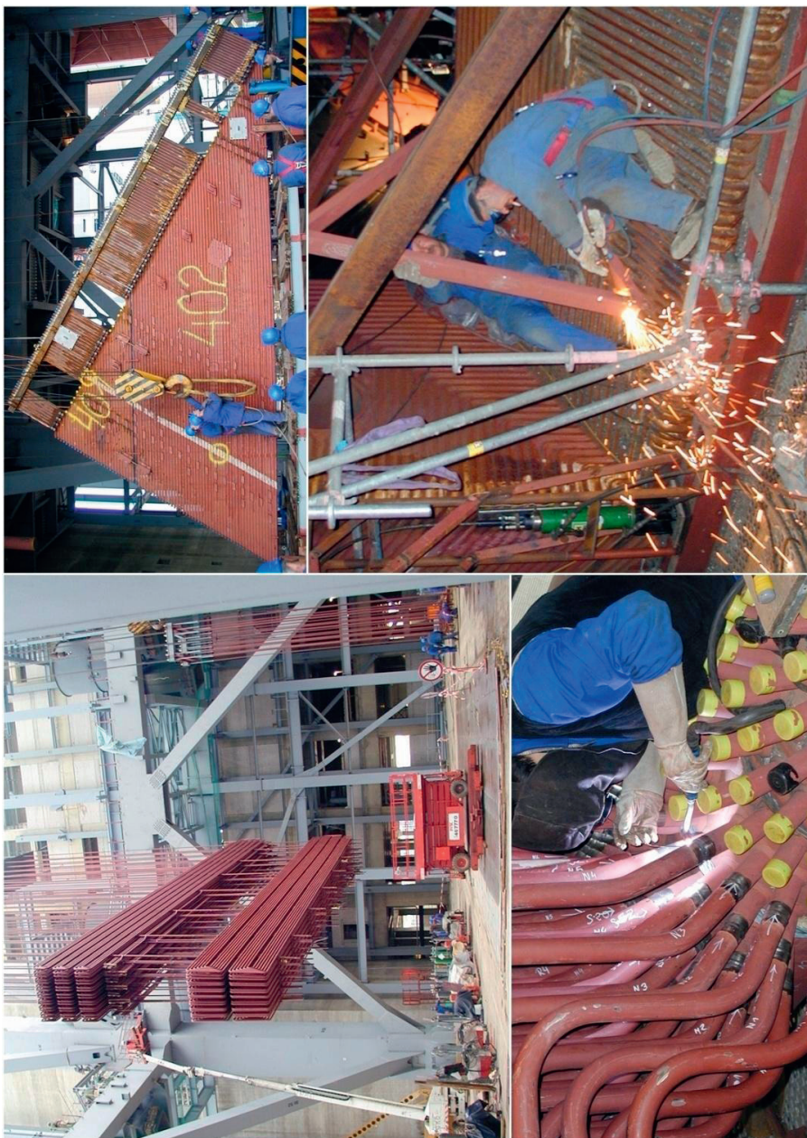
Rys. 1. Montaż elementów ciśnieniowych w czynnych obiektach elektrowni Niederausen, fot. archiwum Remak SA
