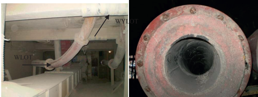
Rys. 5. a) Kolana początkowych fragmentów układu do transportu cementu, b) przekrój wylotowy kolana po demontażu ze śladami erozji
