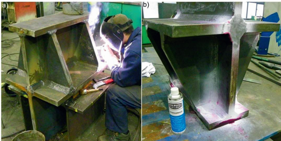
Rys. 9. a) podpora w czasie spawania, b) badanie penetracyjne spoin, naniesiony wywoływacz w postaci białego proszku, kolor różowy to penetrant ujawniający nieciągłość spoiny
