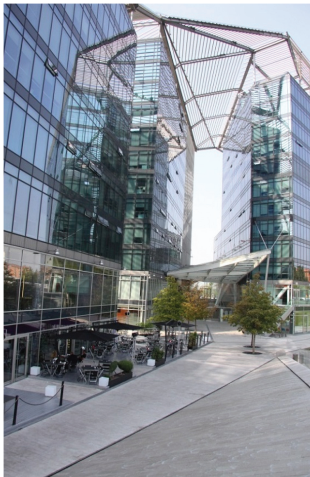
Il. 3. Siedziba Rady Miejskiej w Bolonii, Mario Cucinella Architects, 2008, woda spływająca po kamiennej ścianie nawilża i schładza powietrze, poprawiając mikroklimat w strefie publicznej między budynkami (fot. B. Widera, 2012)
