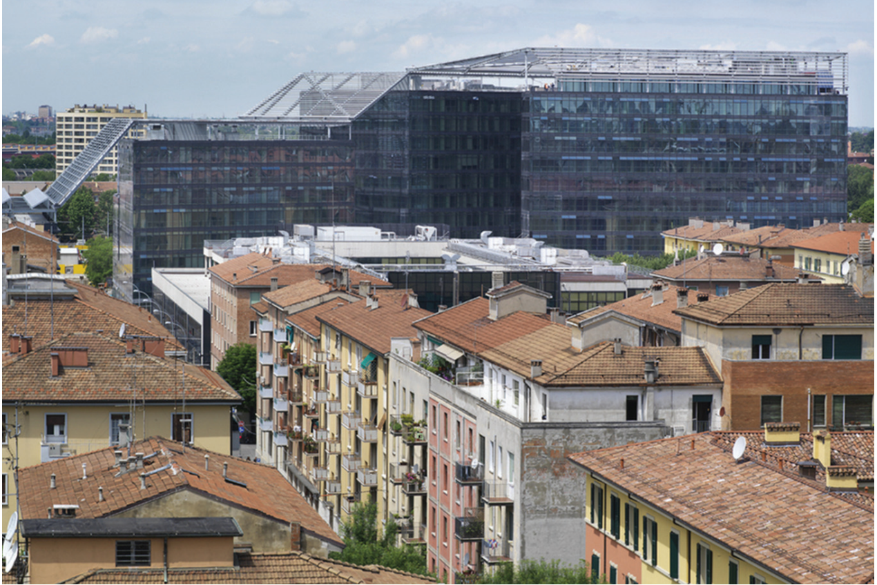
Il. 2. Siedziba Rady Miejskiej w Bolonii, Mario Cucinella Architects, 2008, widok od wschodu.
