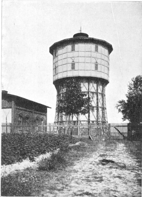
Abb. 9. Wasserturm der Stadt Beuthen.
