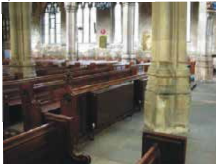
Rys. C.9. Przykłady grzejników zamontowanych w obiektach sakralnych. a) grzejnik rurowy z dodatkowym ożebrowaniem zainstalowany w Warszawie na Powązkach w kościele przycementarnym św. Karola Boromeusza, b) stalowy grzejnik dekoracyjny, c), d) stalowy grzejnik płytowy
