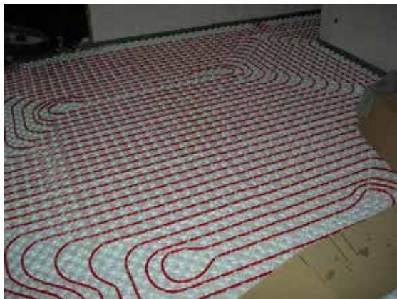
Rys. C.7. Przykład wykonanej instalacji ogrzewania podłogowego wodnego przygotowanej do wylania posadzki betonowej
