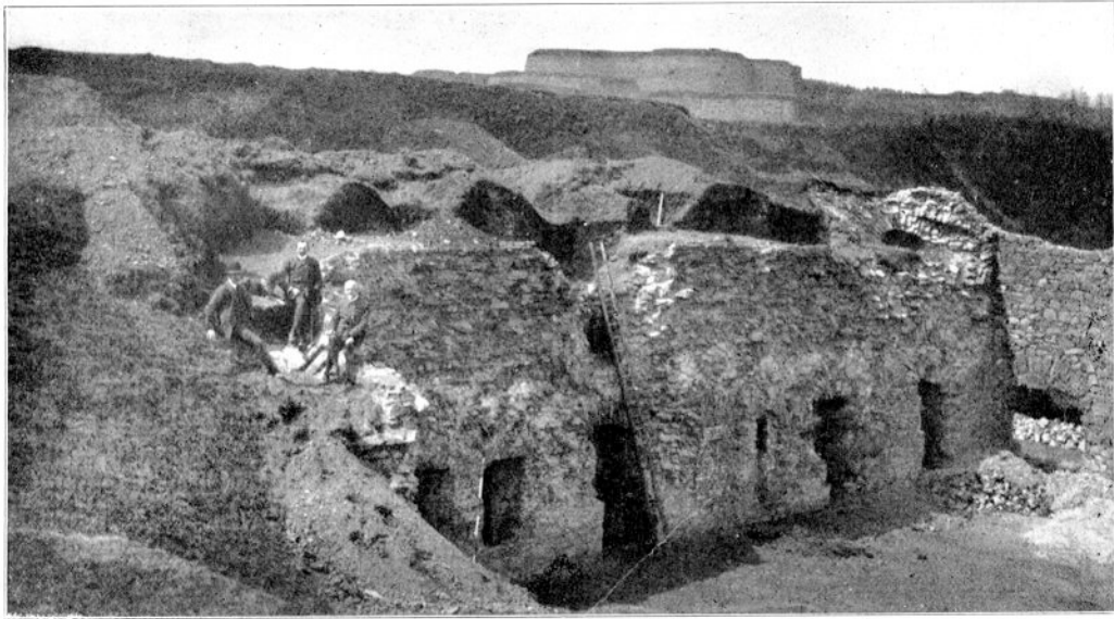
Bauarbeiten auf Fort Spitzberg Innenhof Am Hintergrunde der Donjon
