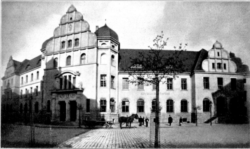
Das neue Postgebäude in Hirschberg i. R.
