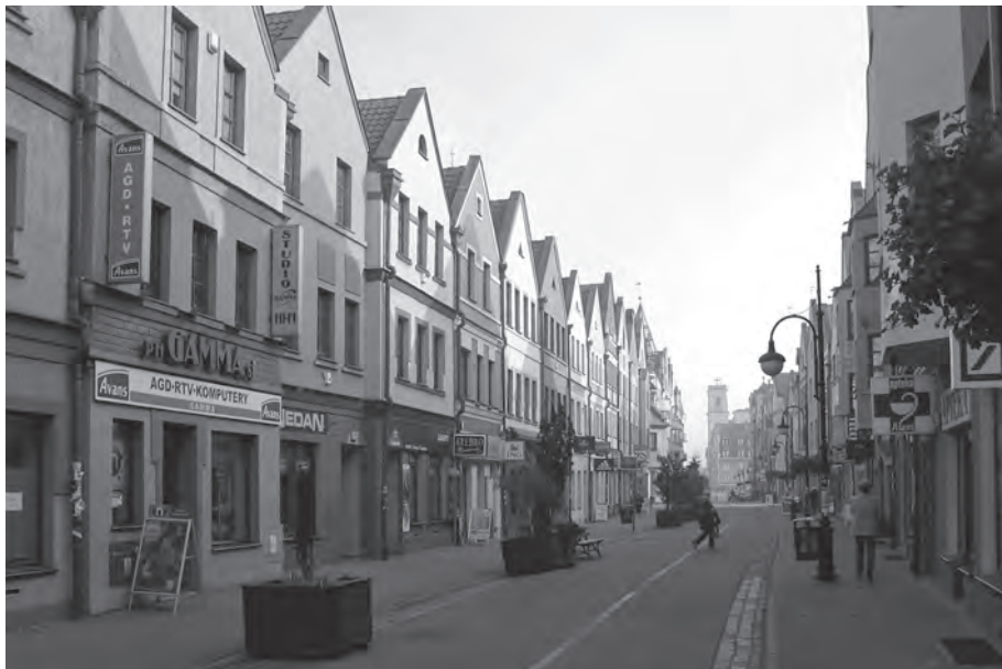
Ryc. 3. Odbudowa pierzei ulicznej w Starym Mieście w Głogowie. Odtworzona parcelacja i skala zabudowy miasta lokacyjnego. Modularność i monotonia będąca efektem zastosowania identycznych rozwiązań architektonicznych w systemie deweloperskim zostaje w nieprawidłowy sposób przełamana cofnięciami niektórych elewacji w głąb od obowiązującej linii zabudowy
