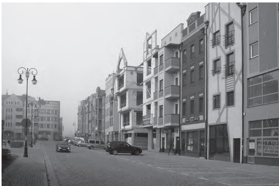
Ryc. 4. Odbudowa pierzei rynkowej w Głogowie. Rozrzeźbienie elewacji, nadekspersja form, kolorystyki, pseudohistorycznego detalu powodują zniekształcenie krajobrazu kulturowego miasta
