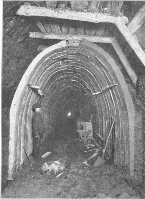
Abb. 49. Streckenausbau aus Eisenbeton.
