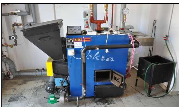
Rys. 23 – Kocioł „ISKRA” zasilany miałem węglowym [18]
