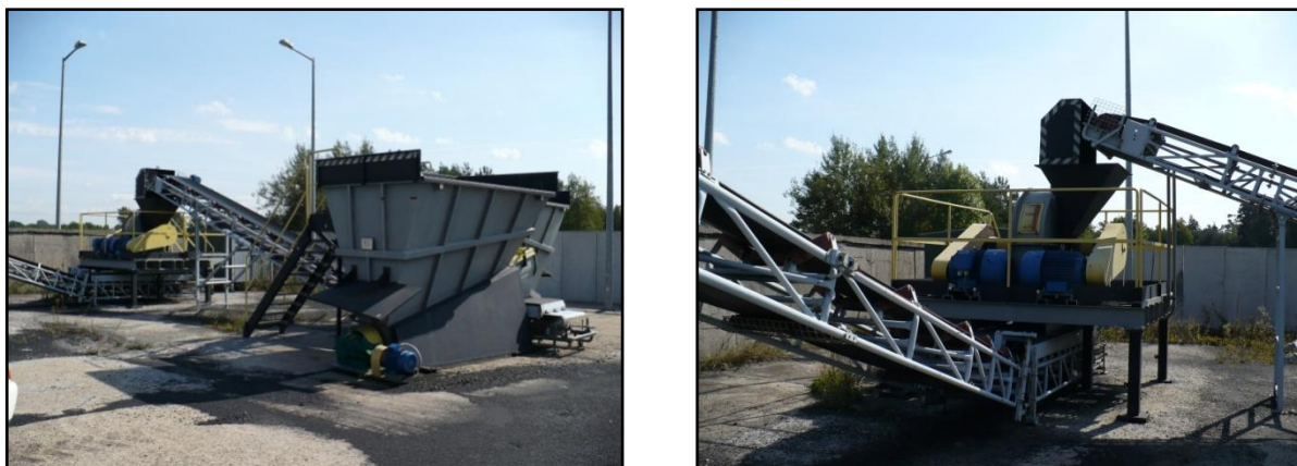
Rys. 8 – Stacja mieszania biomasy z sortymentami węgla [56]
