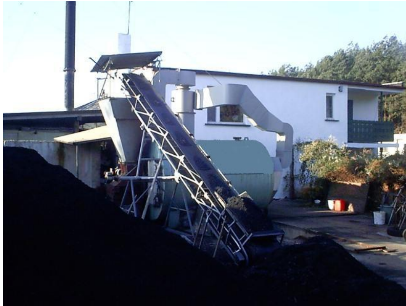
Rys. 6 – Kocioł „Zębiec” o mocy 1,1 MW zainstalowany w ogrodnictwie w Chrzastowicach koło Opola
