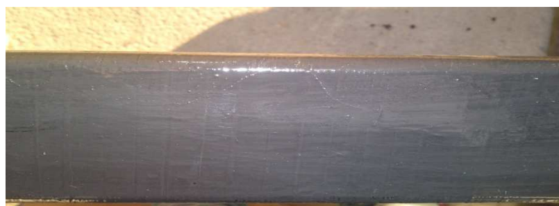
Rys. 6.21. Pręt hydrogeneratora po naprawie zewnętrznej ochrony przeciwjarzeniowej
