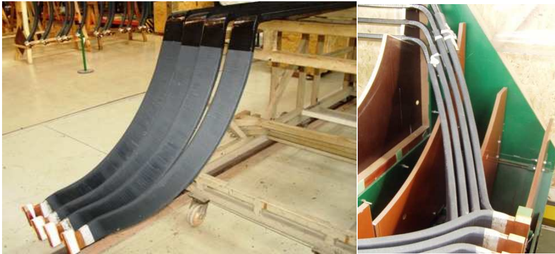
Rys. 5.42. Pręty stojana generatora WY21Z-097LLT: a) na stacji prób elektrycznych podczas próby przebicia, b) w makiecie technologicznej
