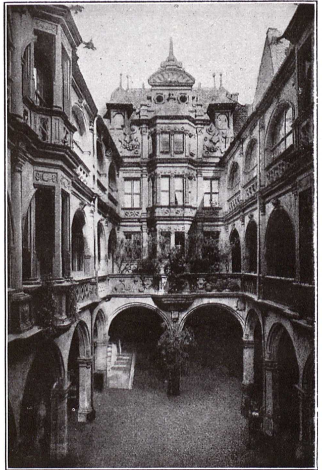
371. Der Hof des Dellerhauses in Nürnberg. Hof mit offenen Galerien.
