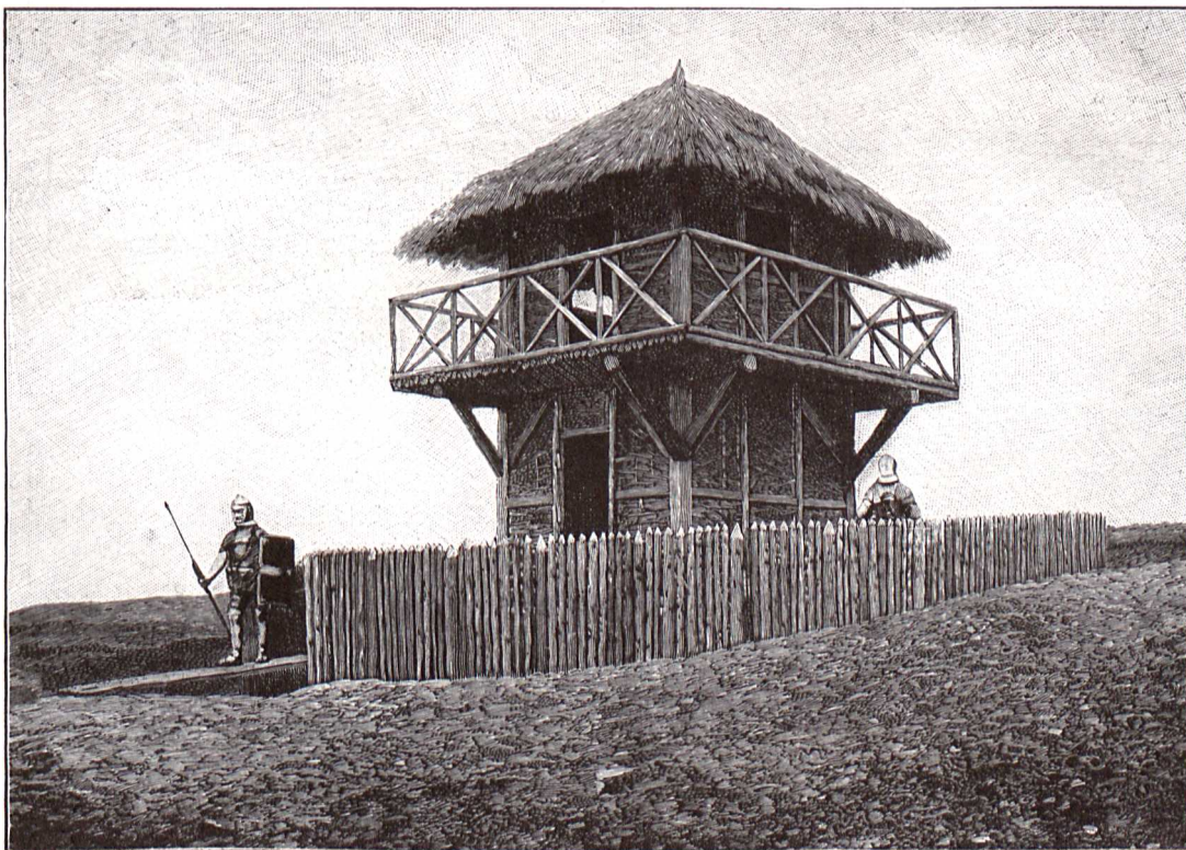
181. Rekonstruktion eines hölzernen Wachturmes am Limes bei Butzbach (Oberhessen). Turm aus Holz und Fachwerk, Holzgalerie, Ginsterdach, davor Palisadenzaun. — J. J. Weber, Leipzig.
