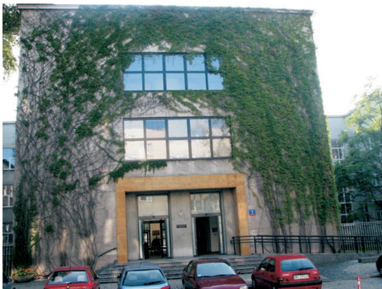
Fot. 4. Główne wejście do gmachu chemii od ul. Pasteura – sierpień 2007 r.
