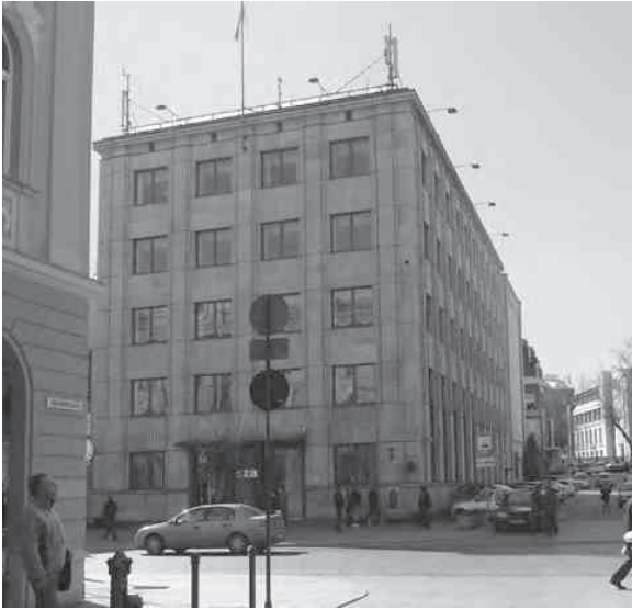
Fig. 4. Vilnius. Building of Powszechna Kasa Oszczędności, designed by Zbigniew Puget and Juliusz Żórawski, (photo by M.J. Żychowska, 2009)
