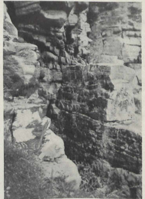
Bild 8. Einzelheit aus dem Kliff des Bildes 5: Klüftung und Schichtung des Sandsteines bedingen den Ausbruch rechtwinklig begrenzter Blöcke, die sich aus der Wand lösen und auf der nächstliegenden Geländestufe liegen bleiben. Sie hinterlassen im Kliff eine rechtwinklig begrenzte Nische (vgl. auch das Titelbild)
