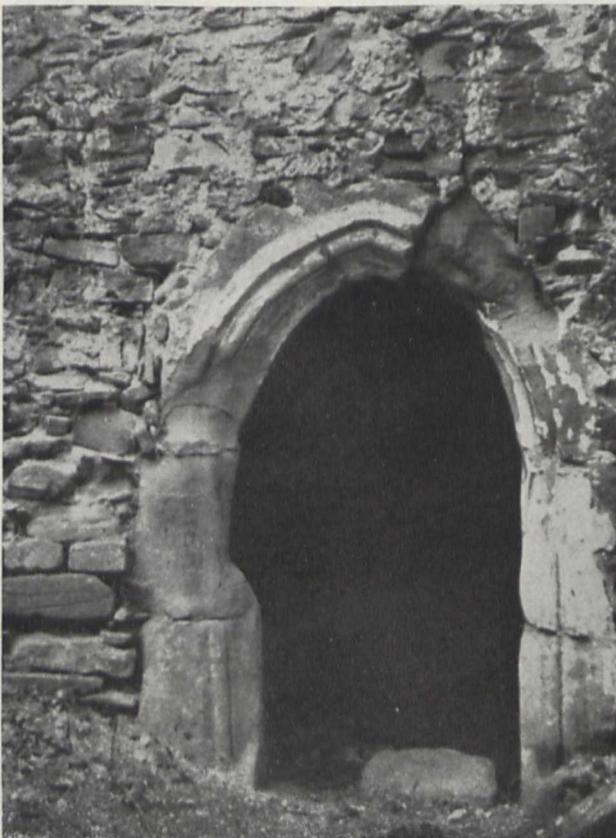
Bild 7. Torbogen der Ruine der Kirche St. Cäcilia in Perersdorf (Niederdonau). Durch Brand ist der Sandstein rot verfärbt und teilweise abgesprungen. Durch Verwitterung sind die Formen weicher geworden
