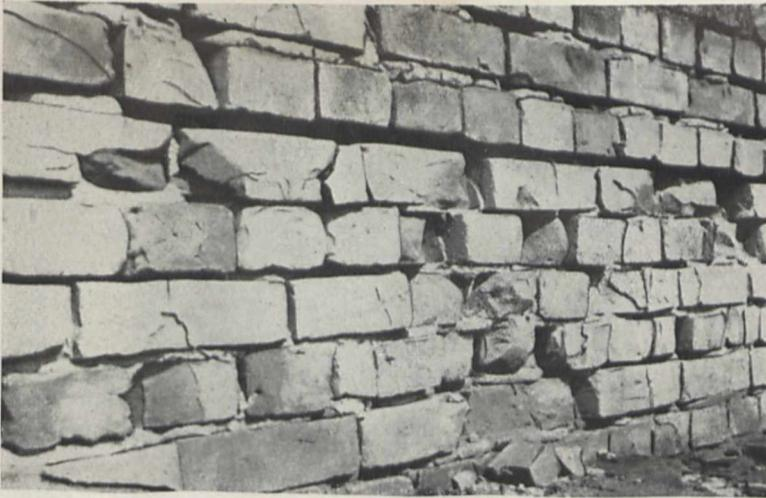
Bild 4. Backsteinmauer im Inneren der Berliner Staatsoper. Durch den Brand sind scharfkantige Scherben abgesprungen; der Fugenmörtel ist zerstört
