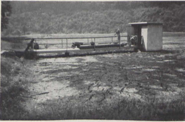
Bild 3. Offener Schlammfaulraum zwischen einfachen Erddämmen
