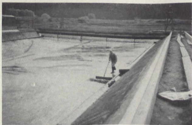
Bild 2. Ein Becken von Bild 1 wird ausgeschlammmt
