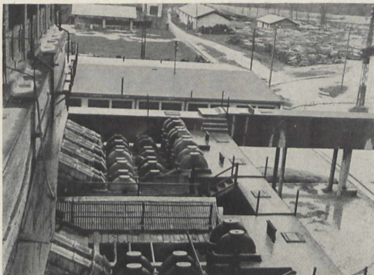
Bild 1. Wasserberieselte Röhrenkondensatoren mit Schachtföfen (links)
