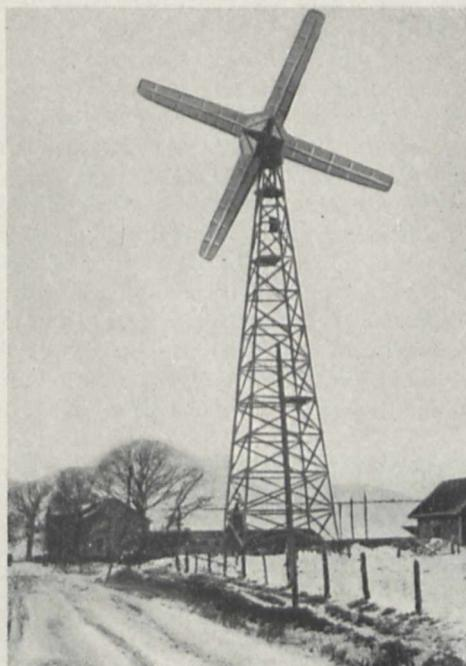
Bild 2. Moderner Windmotor zum Antrieb einer Wasserpumpe
