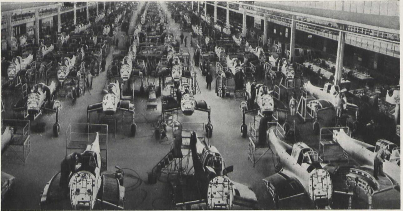
Bild 2. Blick in eine der Montage-Hallen der Junkerswerke, in denen die Sturzkampf-Flugzeuge mit ihren 1200 PS starken Motoren zusammgebaut werden Bild 1 und 2: Foto J. F. M.
