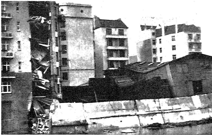
Abb. 89. Hauseinsturz in Hamburg.
