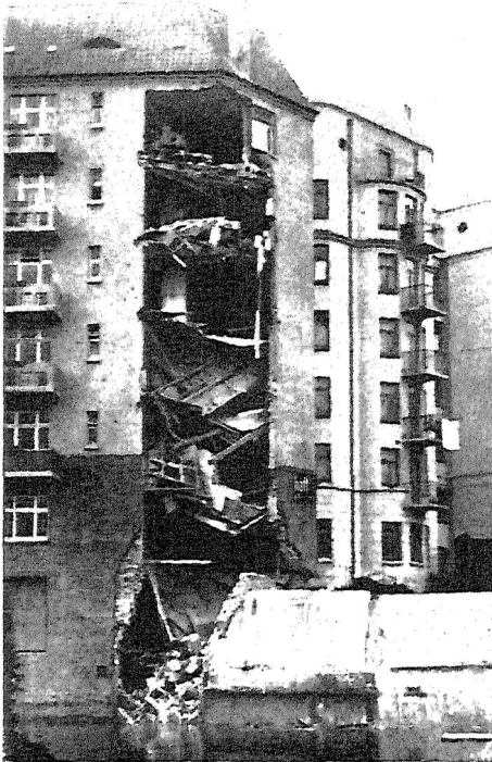
Abb. 90. Hauseinsturz in Hamburg.
