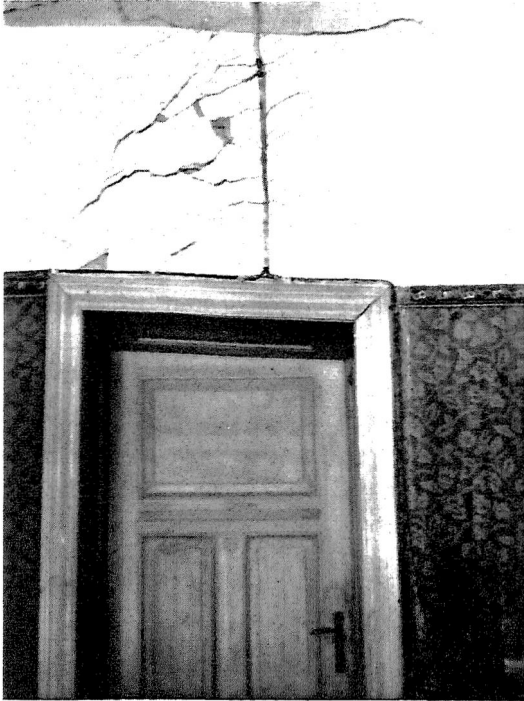
Abb. 71. Zimmertür in einem Gebäude in der Fritschestraße in Charlottenburg.
