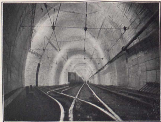
Bild 7. Verwendung von Starkstromleuchten im Förderbetrieb unter Tage
