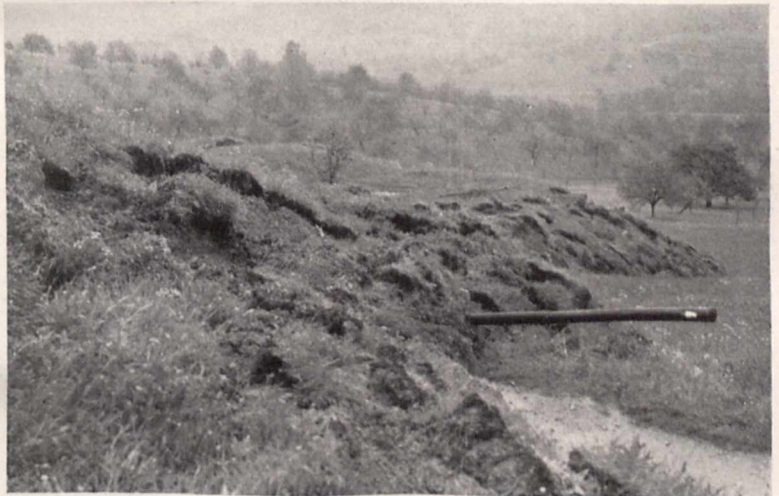
Bild 2. Rand der Rutschung am Ursulaberg. Umgelegte Telegraphenstangen
