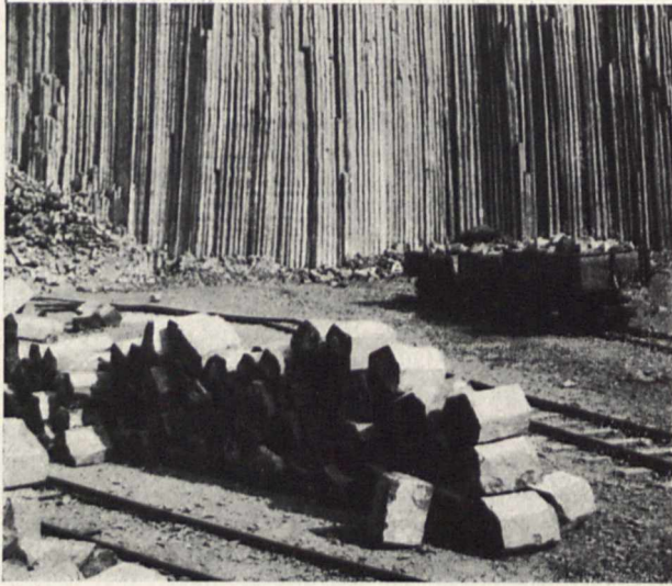
Bild 1. Säulen im Bruch von Beilstein im Dillkreis, die als Senksteine nach Holland geliefert werden. Im Hintergrund die Bruchwand
